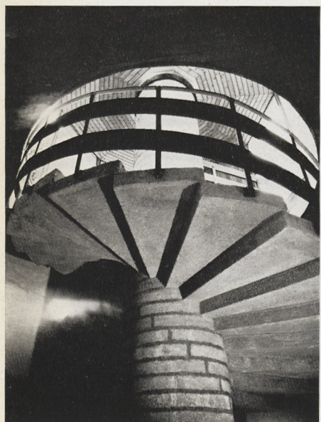
Abb. 17 3. Wiederherstellung des Wohnturmes von Burg Visegrad
