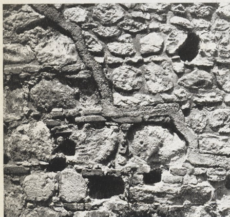
Abb. 5 Der Unterschied zwischen alt und neu wird durch einen Mörtelstreifen gezeigt
