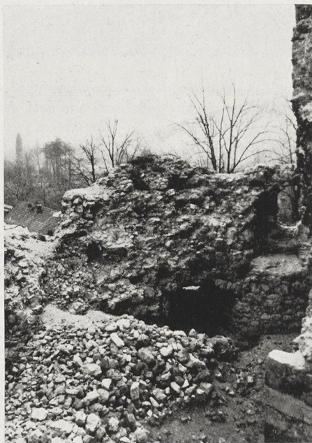
Abb. 7 Das Rondell der Burg Diósgyőr vor den Wiederherstellungsarbeiten
