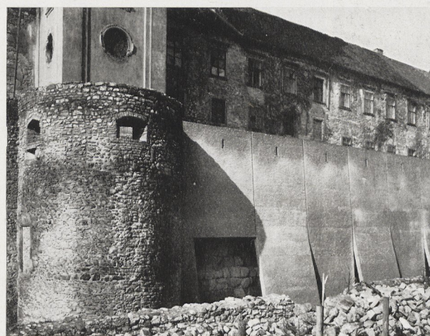
Abb. 12 Der eingestürzte Teil der Stadtmauer von Sopron wurde 1968 mit einer neuen Betonwand ergänzt, die auch die römischen Mauerteile sehen läßt 3) : Arch. Mme J. Kiss-Nagypál
