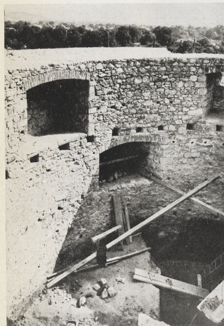
Abb. 8 Das Rondell der Burg Diósgyőr während der Herstellungsarbeiten
