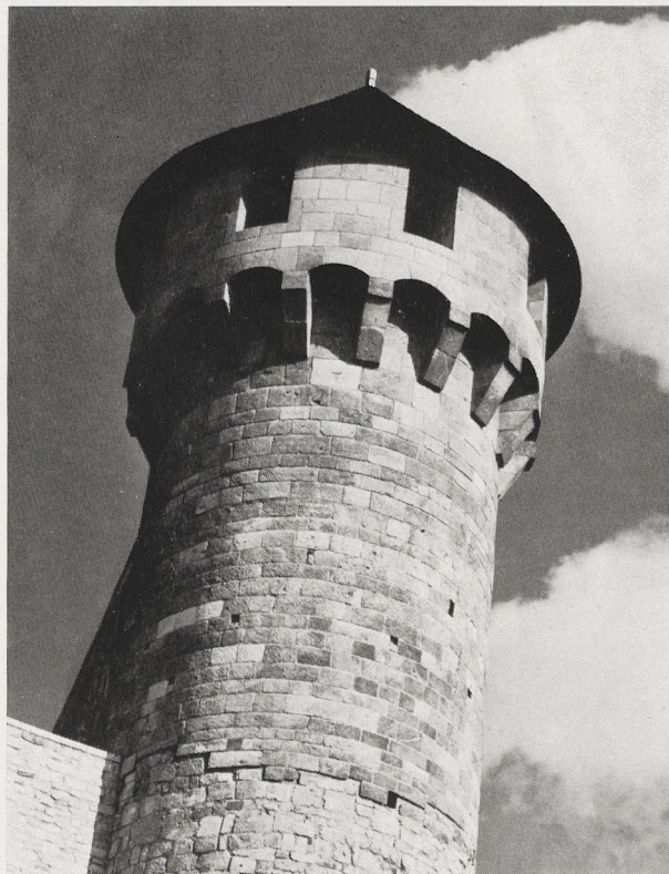
Abb. 4 Die ergänzten Teile des Turmes (Buda) wurden mit groben Formen und mit Trennungslinie gezeigt 2)
