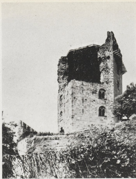
Abb. 15 Der Wohnturm von Burg Visegrad nach dem Brand von 1948. Aufnahme 1960
