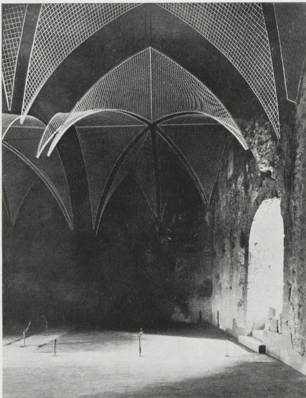
Abb. 13 Wohnturm von Burg Visegrad. Gewölbesystem des letzten Stockwerkes wird angegeben durch Drahtgeflecht-Konstruktionen (Arch. J. Sedlmayr)
