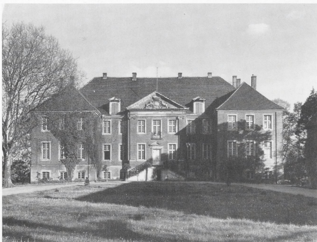
Abb. 5. Drensteinfurt (Foto: Westfälisches Amt für Denkmalpflege).
