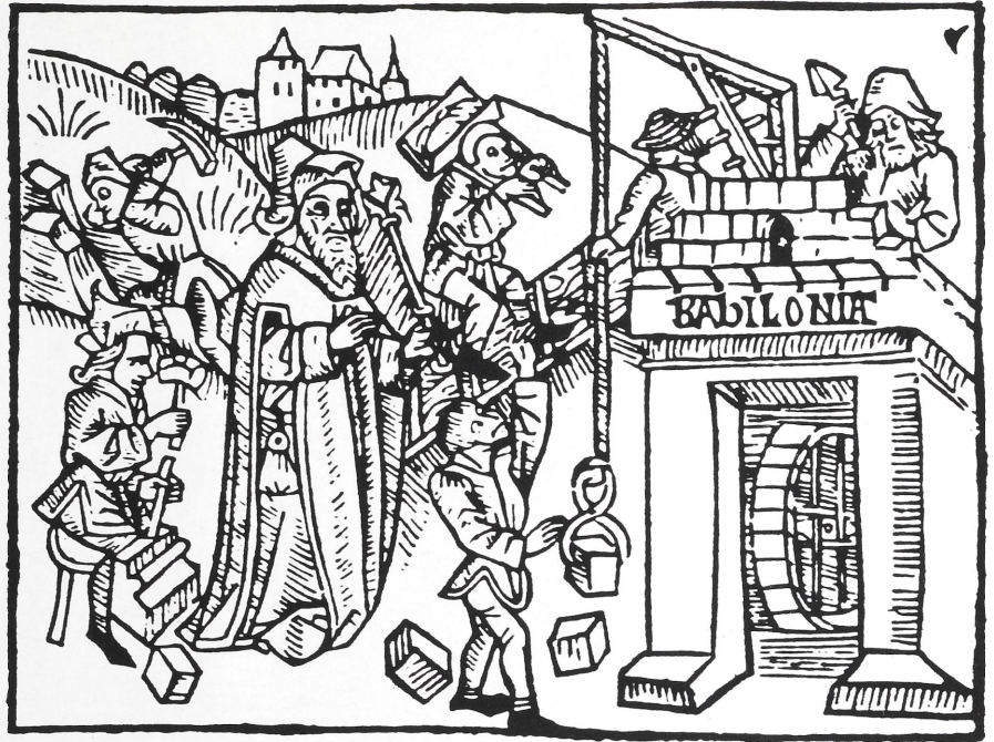
Abb. 7. Turmbau, Straßburg 1485. Das Tretrad steht im wettergeschützten Erdgeschoß des Turmes, der Mast wird mit wachsendem Bauwerk nach oben versetzt und in je zwei Deckenebenen gehalten.
