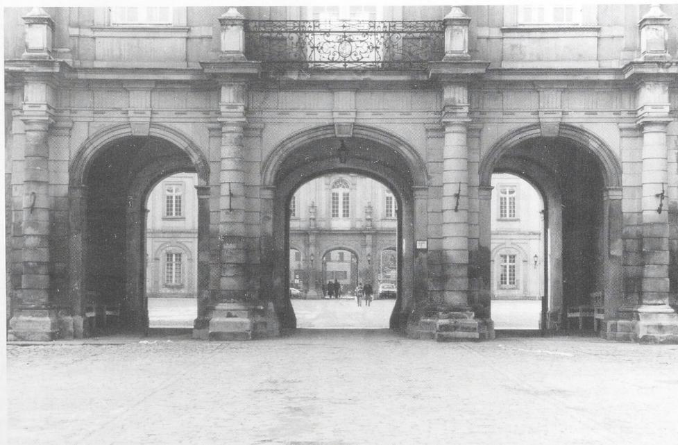
Abb. 3. Schloß Ludwigsburg. Aufsteigende Feuchtigkeit in den Außenmauern.
