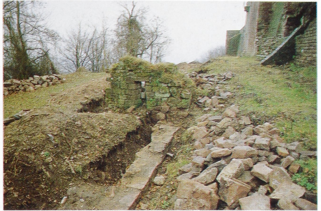
Abgraben der archäologischen Schichtanschlüsse im Erdreich.
