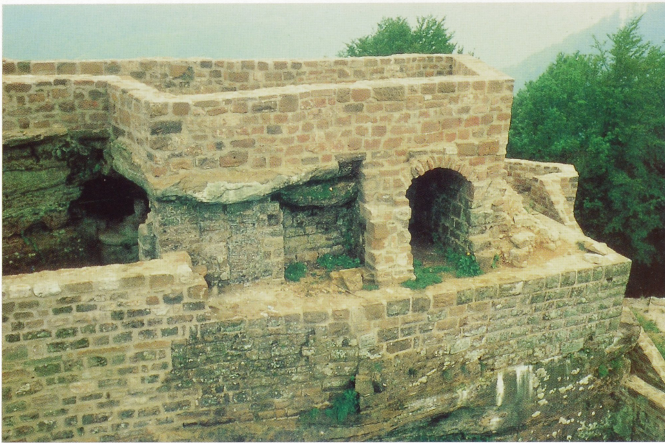
Falsche Brüstungsmauer mit beliebigen Mauersteinen.
