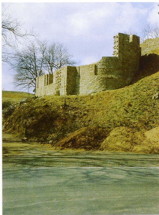
Ursprünglich vorhandenes Mauerwerk zwei Fuß hoch.
