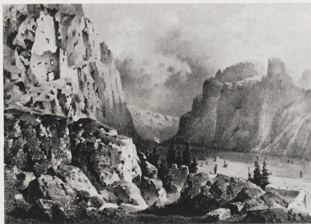
Abb. 1 Höhlenburg Wolkenstein. Zeichnung um 1830 mit den damals noch vorhandenen Resten eines tiefer unten vorgelagerten Vorwerks
