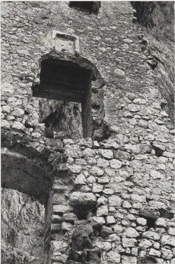
Abb. 3 Höhlenburg Wolkenstein. Teil der einstigen Hauptburg, der mittlere, hochgelegene Eingang über dem vorgelagerten Zwinger; Bild zeigt den Platz des ehemaligen Torwappens. Spuren von Bettungen und Führungen des ehemaligen Balkenwerkes sind zu erkennen
