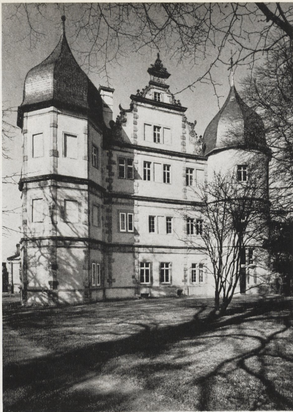
Abb. 5 Barntrup (Kr. Lemgo), Schloß, Ansicht von Osten, errichtet 1584/89 für die Gattin des Franz v. Kerßenbrock, Anna v. Canstein, von Eberhard Wilkening
