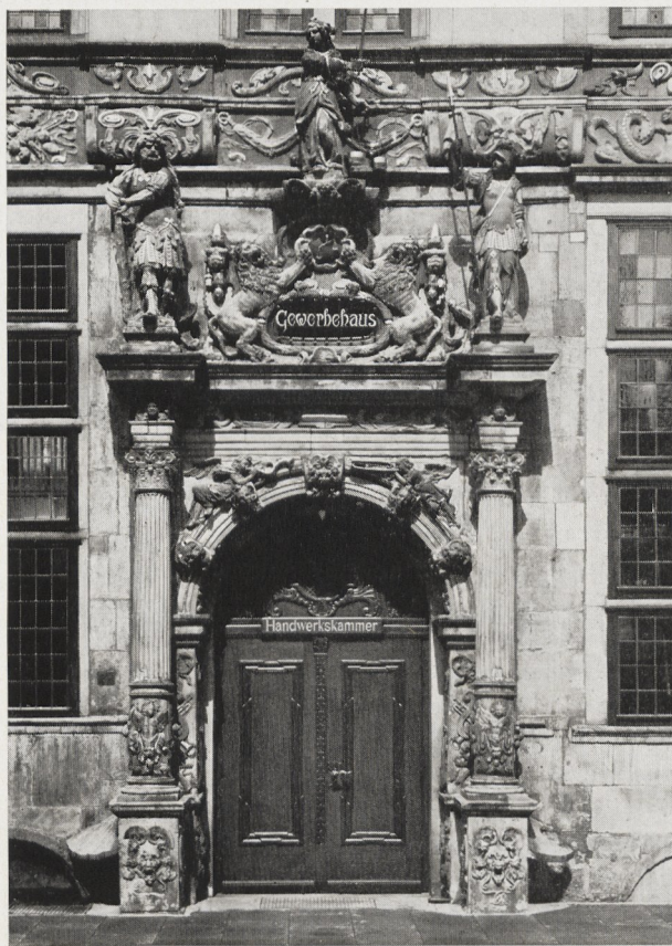
Abb. 10 Bremen, Gewerbehäus (ehemal. Hochzeitshaus der Gewandschneider) von 1619/22, Hauptportal. Baumeister und Bildhauer Ernst Crossmann aus Lemgo († 1622)
