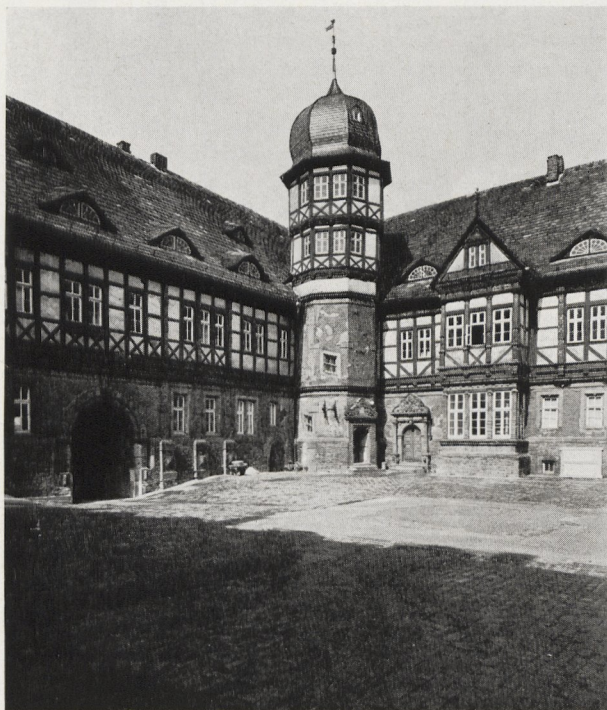
Abb. 9 Bevern (Kr. Holzminden), Schloß, Hofseite mit Treppenturm und Küchenauslucht. Erbaut 1603/12 für Statius v. Münchhausen von Johann Hundertossen
