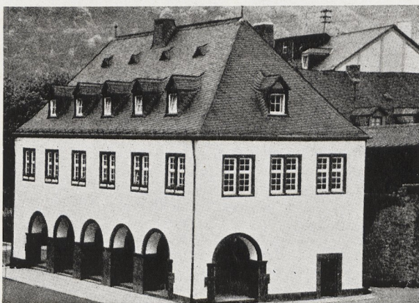
Abb. 2 Der Salhof in Oberlahnstein 1969 nach der Instandsetzung. Rechts ein Teil der Stadtmauer.
