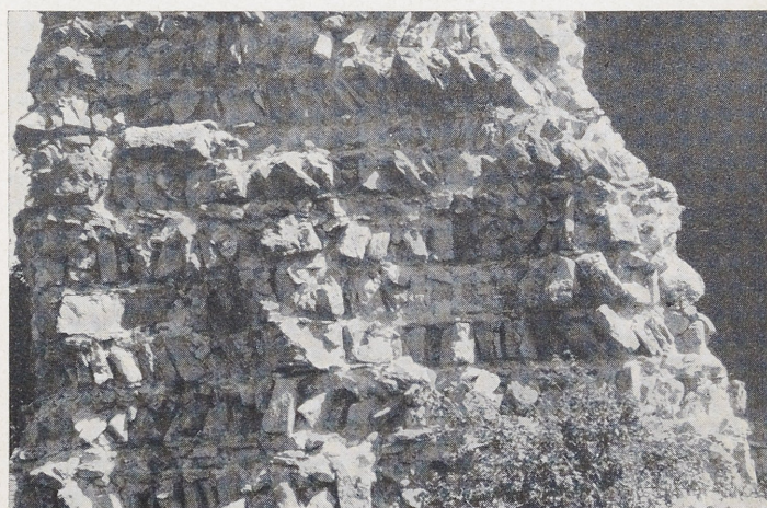
Abb. 3 Burg Schweinberg. Bruchsteinmauerwerk im „Fischgrätenverband“ aus dem Mauerkerne des Berchfrit. 1. Hälfte 12. Jh.
