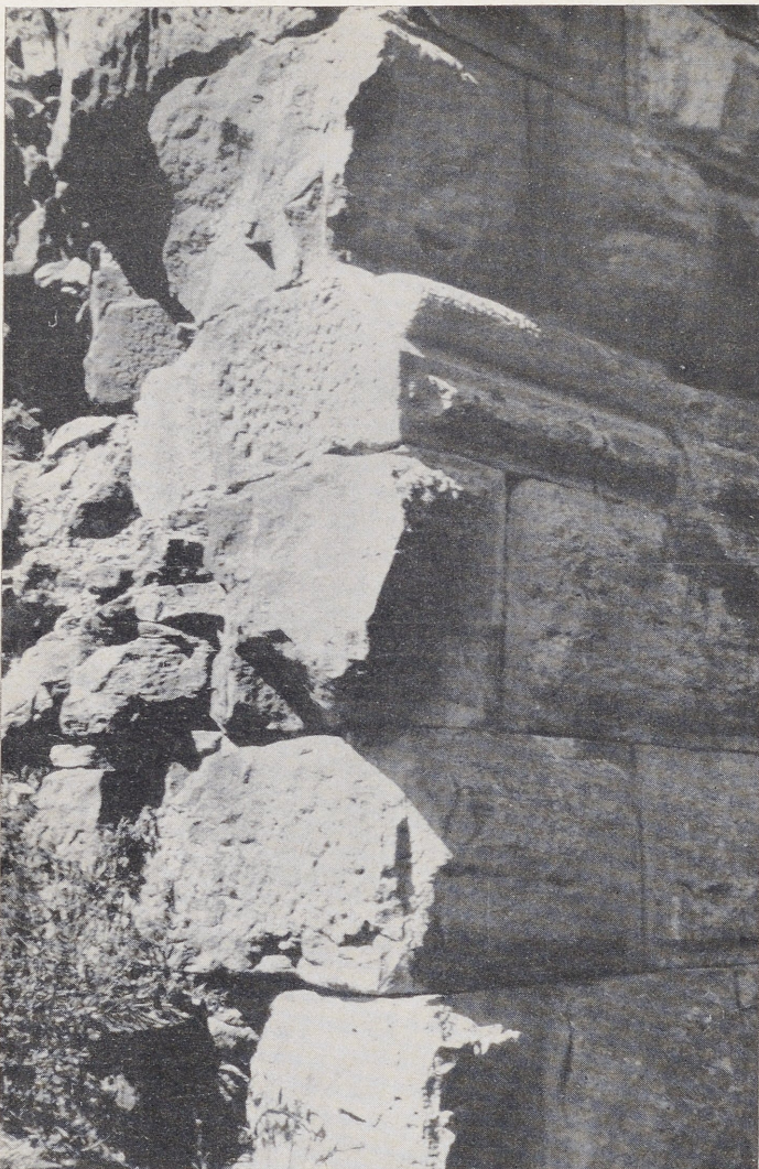
Abb. 4 Burg Schweinberg. Quadermauerwerk des Berchfrits mit Sockelstein. 1. Hälfte 12. Jh.
