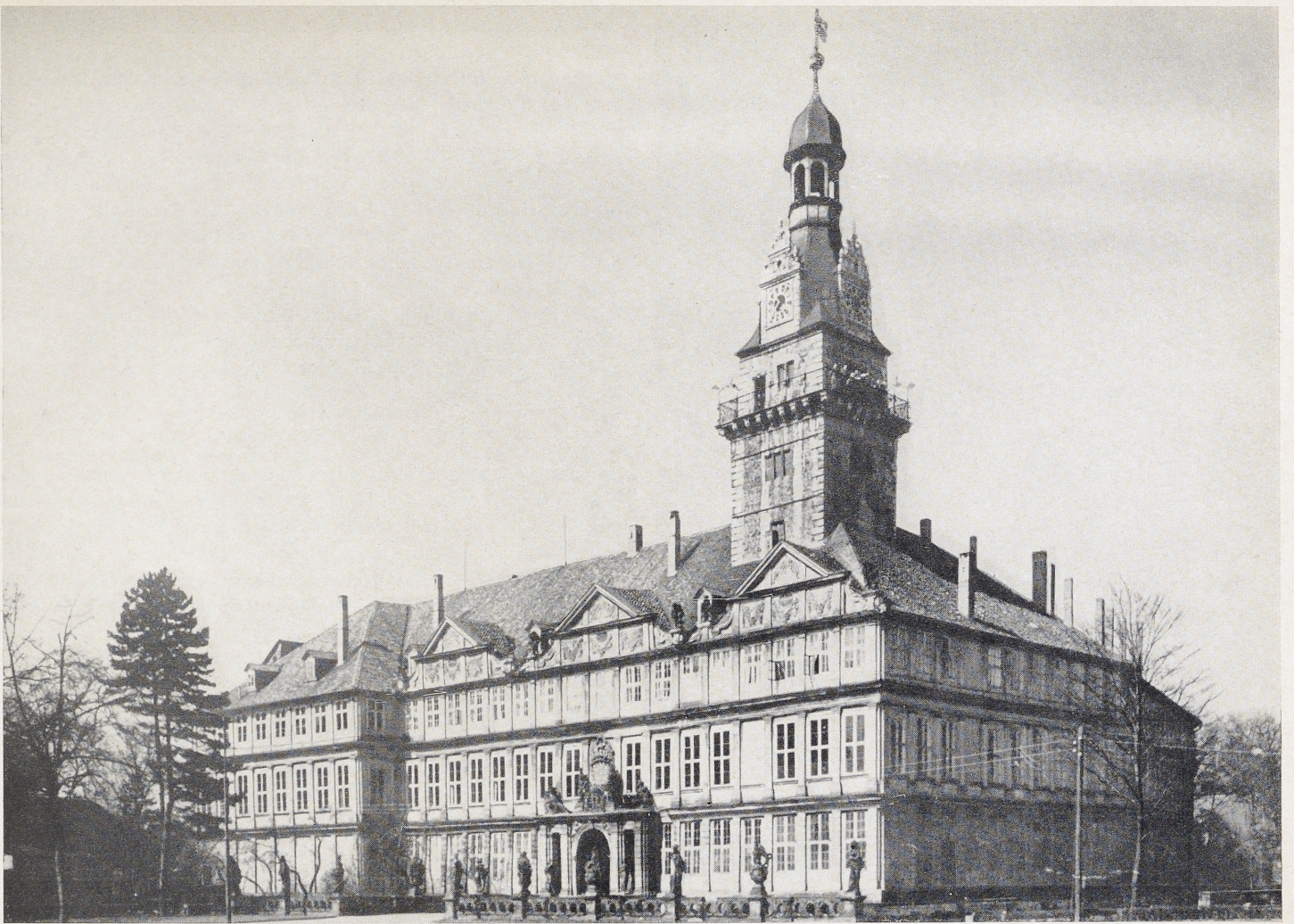
Abb. 5 Schloß Wolfenbüttel von Osten (vgl. Bild 3) mit Fassade von Hermann Korb (1714 ff.) und Hausmannsturm von Paul Francke (1614).
