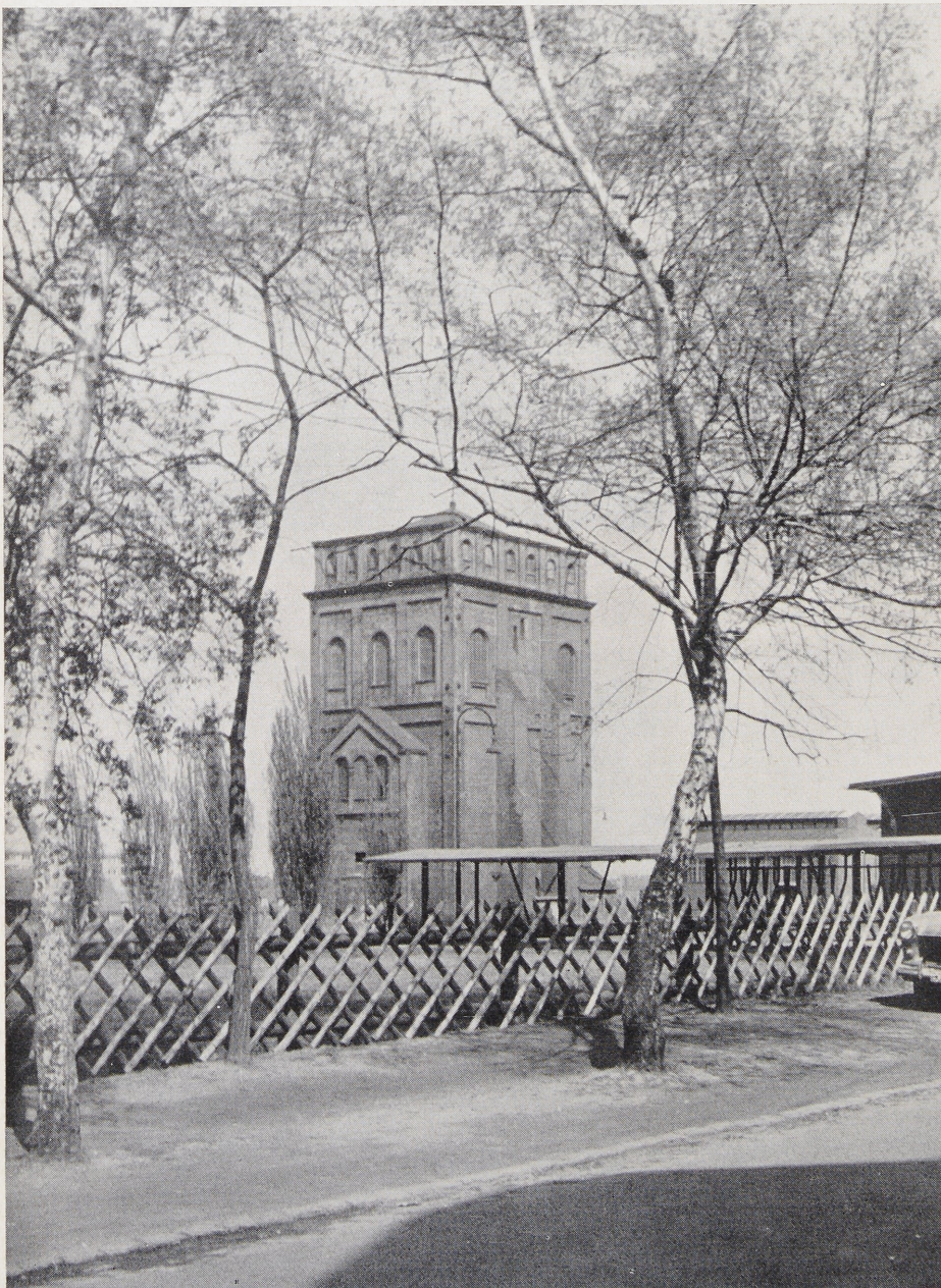
Abb. 11 Gesamtansicht des Schachtes Julius Philipp der Zeche Prinzregent-Dannenbaum in Bochum. Aufnahme 1961.
