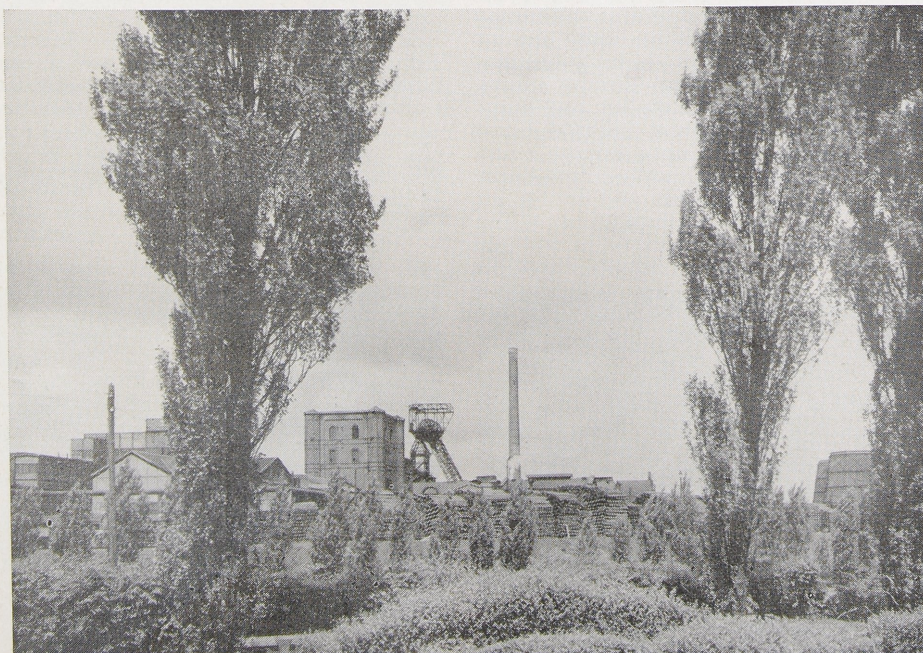
Abb. 13 Gesamtansicht der Zeche Engelsburg in Bochum mit Schachtturm auf Schacht I. Aufnahme 1961.
