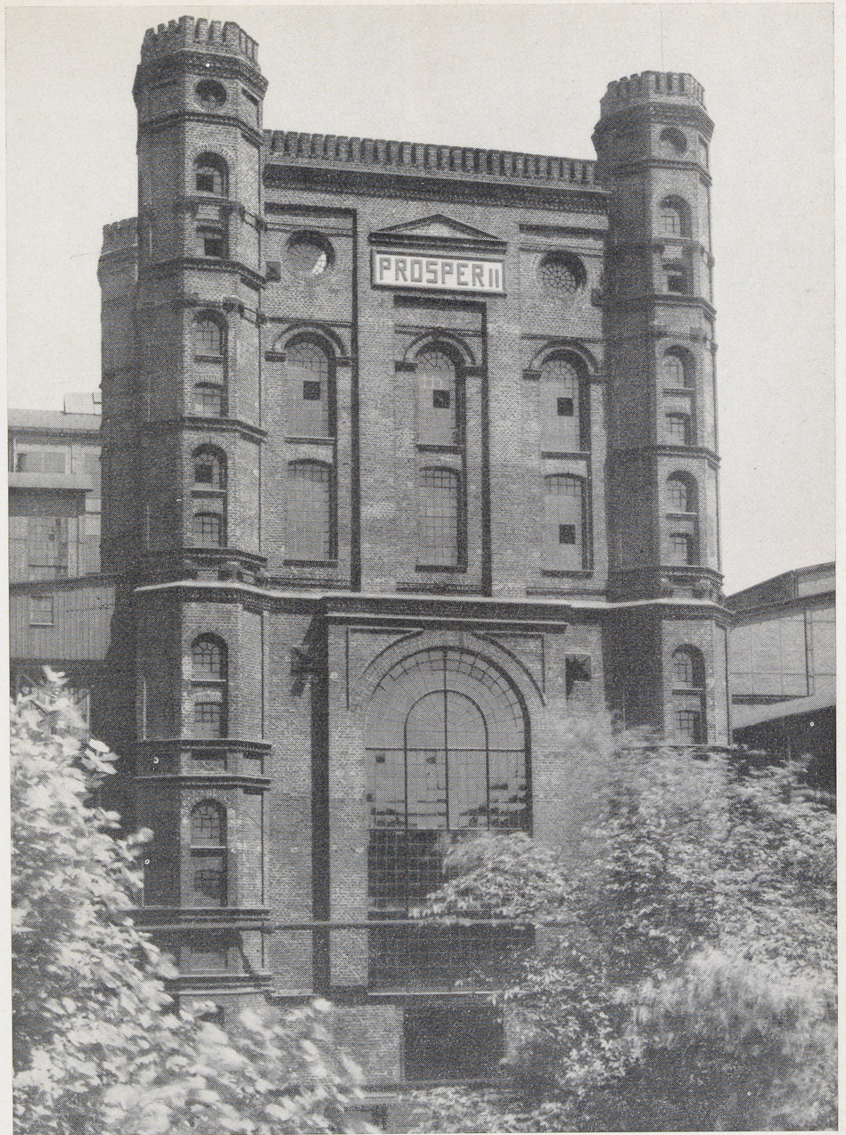
Abb. 6 Schachtturm Prosper 2 in seiner ursprünglichen Bauart. Aufnahme 1931.
