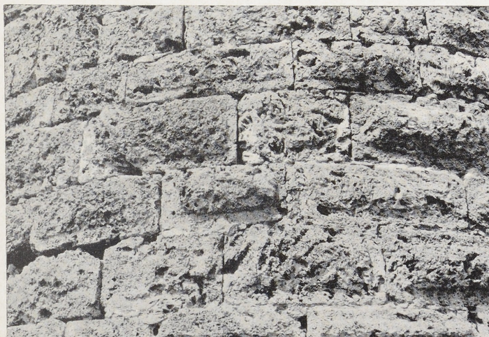
Abb. 24 Burg Krautheim a. Jagst, Buckelquadermauerwerk am Bergfried. Kalktuff.
