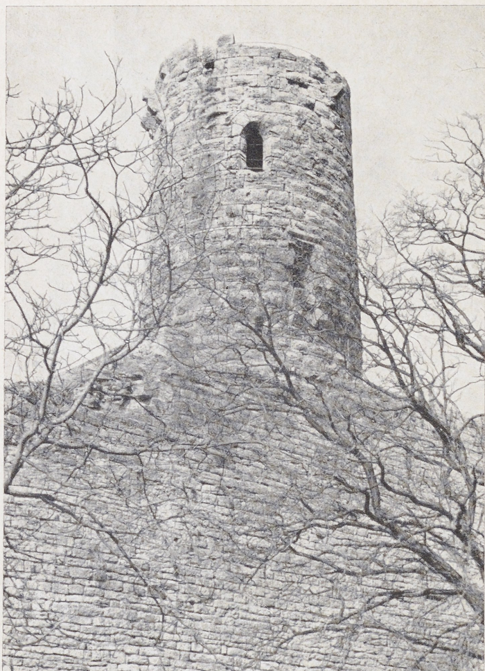
Abb. 20 Burg Krautheim a. Jagst, Bergfried. Buckelquadern aus Kalktuff. 1. Viertel 13. Jh. Im Vordergrund die Schildmauer
