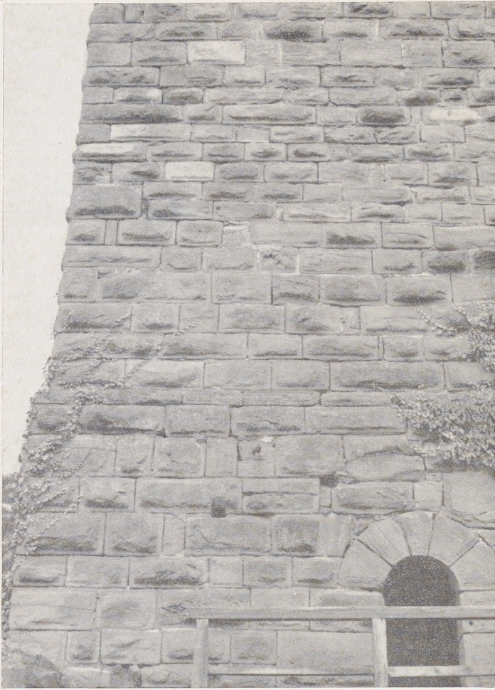
Abb. 17 Hinterburg a. Neckar, Bergfried. Buckelquadern in rotem Sandstein. Um 1200.
