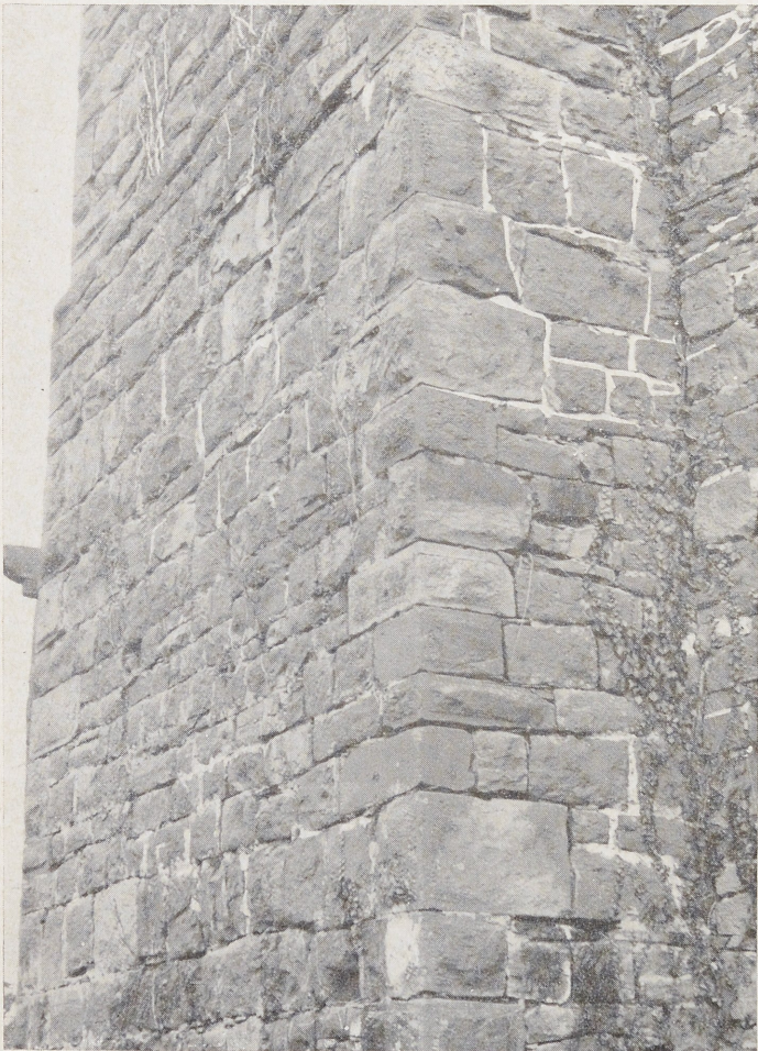
Abb. 18 Minneburg a. Neckar, Bergfried. Hammerrechtes Schichtenmauerwerk mit Bruchstein mit Eckquadern. Roter Sandstein. Nach 1200.
