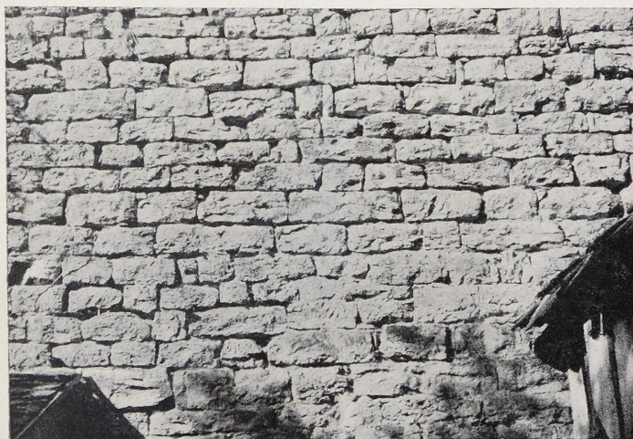
Abb. 25 Burg Krautheim a. Jagst. Mauerwerk der Schildmauer, Muschelkalk.
