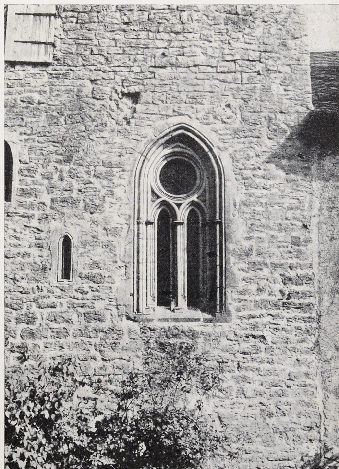
Abb. 23 Burg Krautheim a. Jagst, Hofwand der Kapelle. Lagerhaftes Bruchsteinmauerwerk in Muschelkalk. Architekturteile in gelbem Sandstein. 1./2. Viertel 13. Jh.
