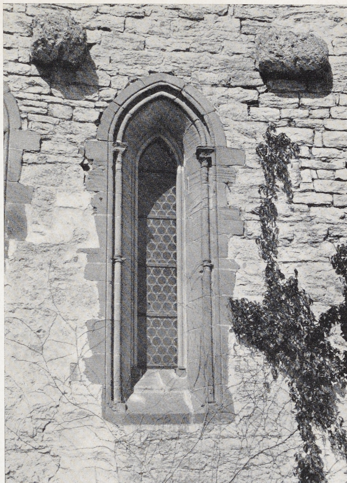
Abb. 22 Burg Krautheim a. Jagst, Südseite der Kapelle. Fenstergewände in Sandstein, Mauerwerk in Muschelkalk, Konsolen in Kalktuff, Putzreste fraglichen Alters. 2. Viertel 13. Jh.
