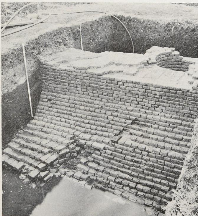
Abb. 4 Abgetreppte Fundamentfüße der südlichen Wehrmauer mit Brunnschacht.
