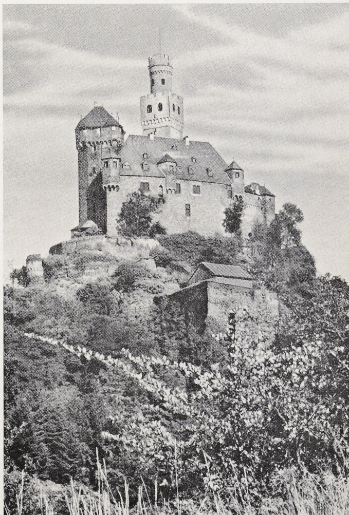
Abb. 7 Burg Katz (Neukatzenelbogen über St. Goarshausen). Gotische Anlage (Ende 14. Jh.) mit rundem Bergfried an der Angriffsseite über dem Halsgraben. Der Wohnbau mit Ecktourellen. Ausbau 1896—98.
