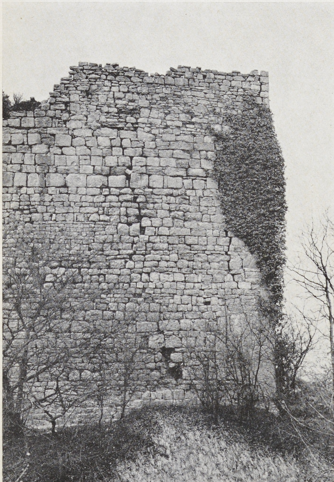
Abb. 35 Burg Lichteneck. Schildmauer. Hammerrechtes Schichtenmauerwerk und Bruchsteine in Muschelkalk. Eckquadern. Um 1250.
