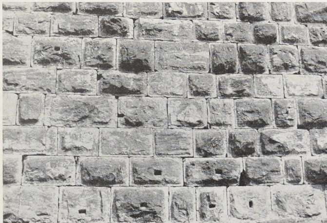
Abb. 30 Burg Brauneck, Bergfried. Buckelquadern aus Muschelkalk. Einzelne Steine mit Wolfslöchern und Steinmetzzeichen.
