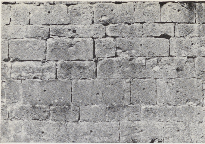
Abb. 33 Burg Bebenburg. Bergfried. Glatte Quadern aus Muschelkalk. Zangenlöcher und Bearbeitungsspuren. 2. Viertel 13. Jh.
