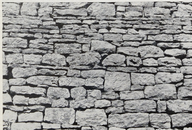
Abb. 31 Burg Brauneck. Nördliche Umfassungsmauer, Ausschnitt. Lagerhafte Bruchsteine. Muschelkalk, um 1220.
