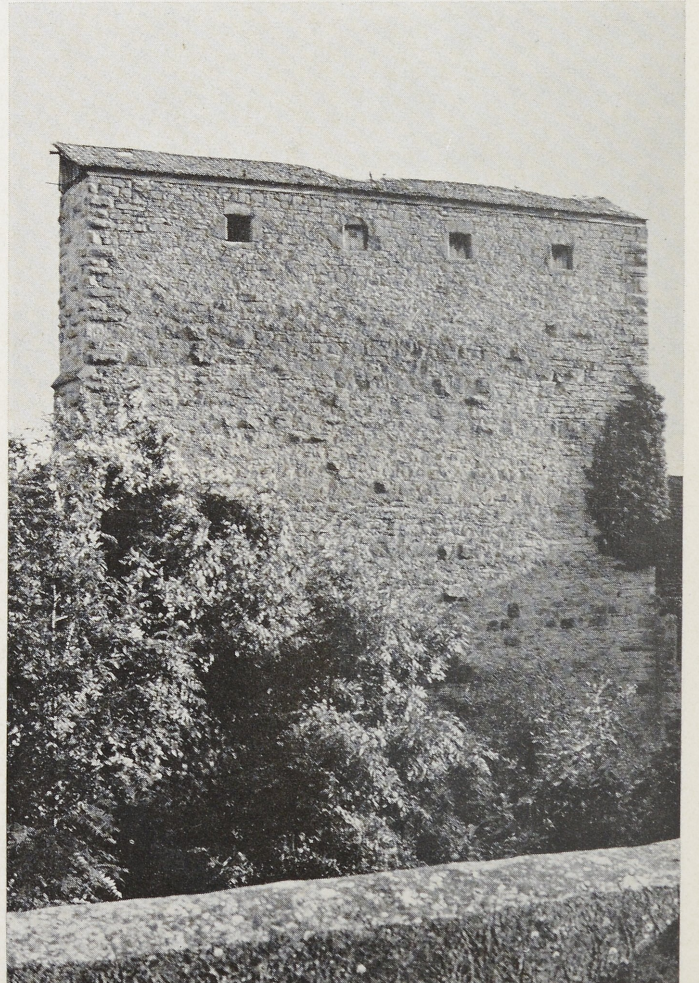
Abb. 36 Burg Amlishagen. Schildmauer. Eckbuckelquadern und Schichtenmauerwerk, sonst Bruchstein. Muschelkalk. Um oder nach 1250.
