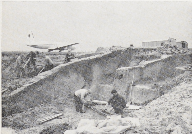
Abb. 5 Motte Ick. Querschnitt durch den Hügel, im Vordergrund Schwelbalken der Brücke, 12. Jahrh.
