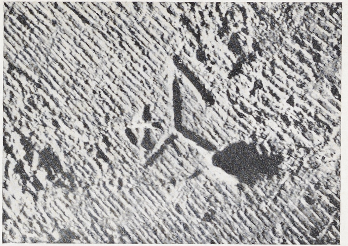
Bild 1 Scharrierter Quaderstein am Ulmer Münster mit dem Steinmetzzeichen des Matthäus Böblinger aus Eßlingen. Etwa \frac{2}{3} natürlicher Größe. (Aus K. Fr. Friedrich, Die Steinbearbeitung)
