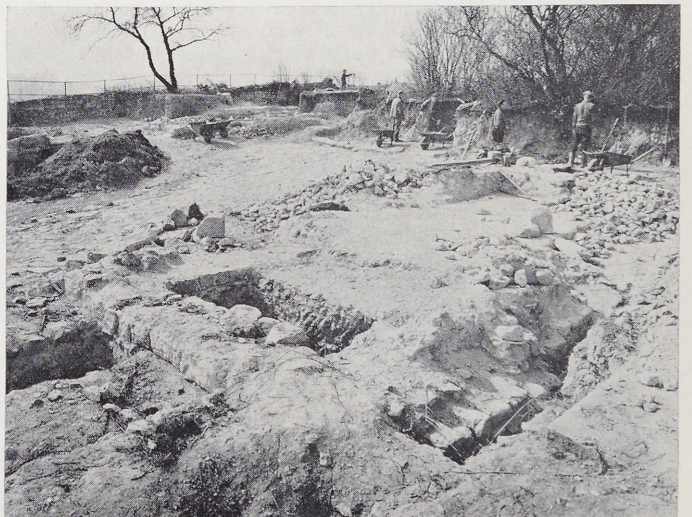
Abb. 12 Halle. Burg Giebichenstein. Freilegungsarbeiten im Winter 1964. (Foto: Detlev Brandt, Halle)
