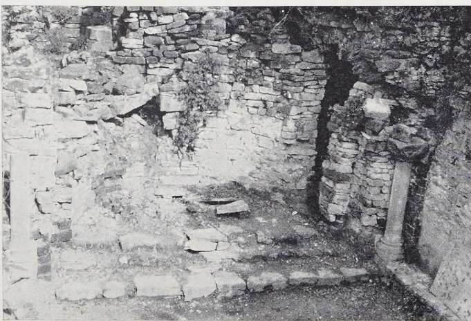
Abb. 13 Burgruine Neuerburg, Kapelle kurz nach der Freilegung. 1964
