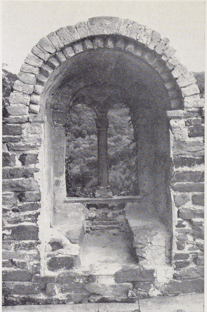
Abb. 16 Burgruine Neuerburg , Fenster des Sommer-Saales nach der Wiederherstellung 1965.
