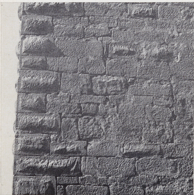
Abb. 44 Waldenburg, Wehrturm an der Bergseite. Glatte Quadern mit Eckbuckelquadern in Keupersandstein. Um oder nach 1250.
