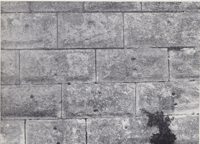
Abb. 49 Burg Niederalfingen. Bergfried. Buckelquadern am Turmfuß mit doppelten Zangenlöchern. Um 1250.
