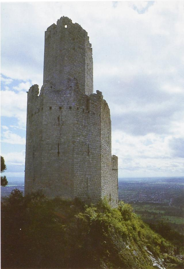
Abb. 11. Ortenberg, Kernburg von Norden; die leichte Dossierung im Sockelbereich der Mantelmauer ist erkennbar, ebenso die Buckelquader in halber Höhe der Eckverbände (Th. Biller 1984).
