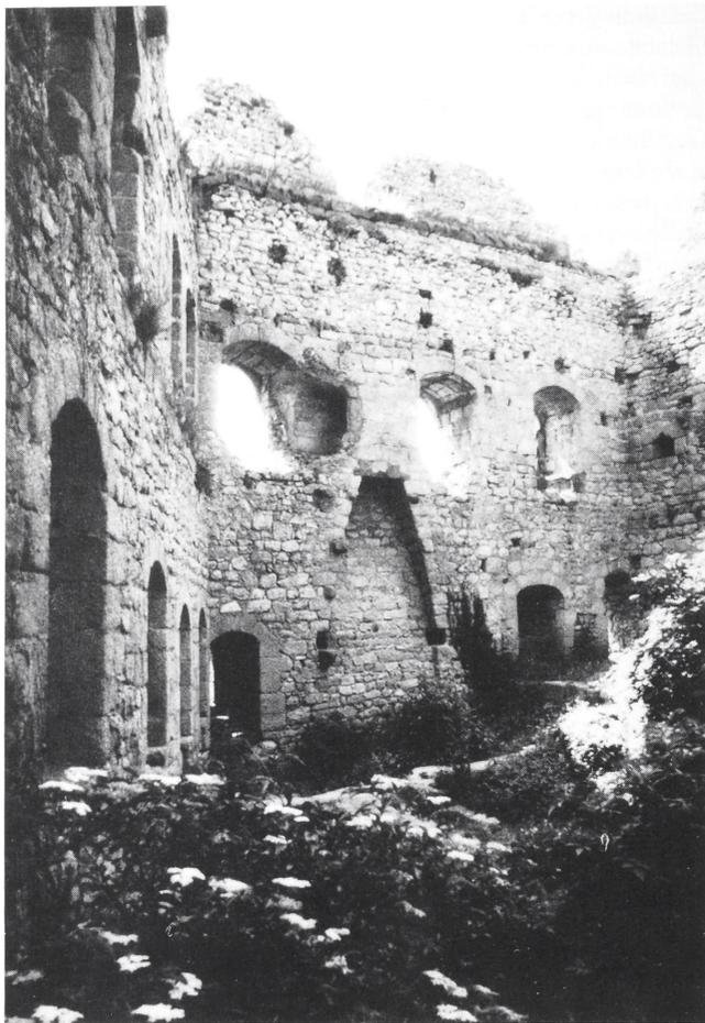
Abb. 14. Ortenberg, Südwand des Wohnbaues gegen Süden; unten links der Küchenbereich, im Wehgangbereich sind die beiden Sandsteinrinnen des ursprünglichen und des erhöhten Daches sichtbar (Th. Biller 1984).
