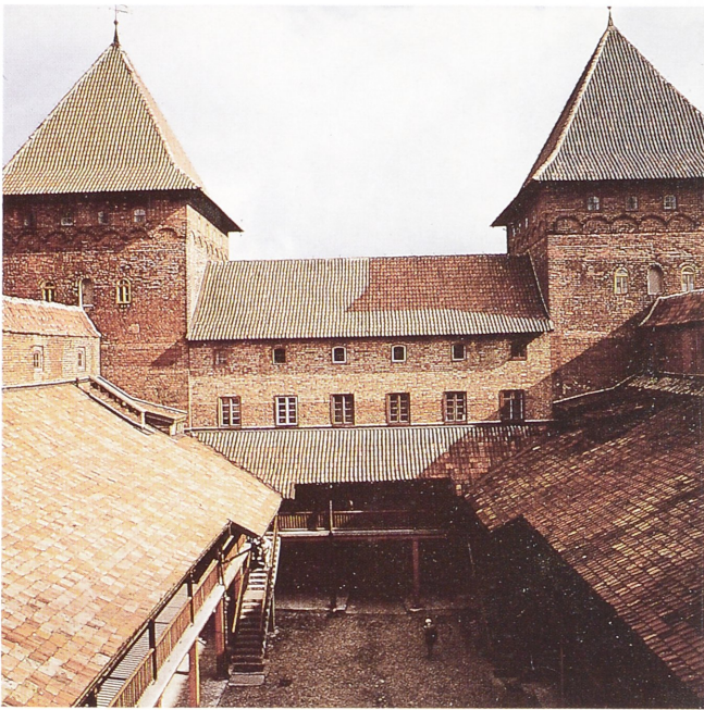
Abb. 10. Deutschordensburg Neidenburg/Nidzica, Ostflügel mit Burghof (Foto: G. Schmitt).
