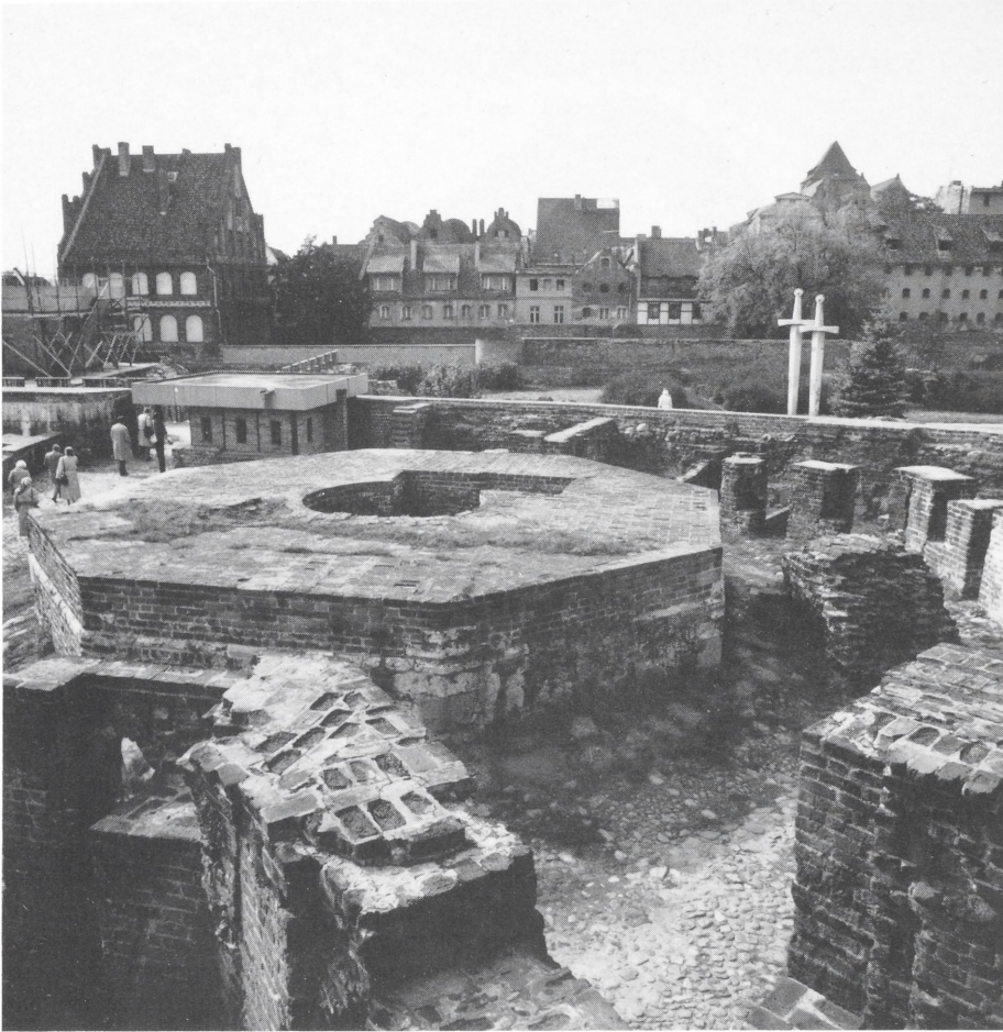
Abb. 2. Deutschordensburg Thorn, freigelegter Sockel des Bergfrieds von Osten (Foto: Günter Schmitt).
