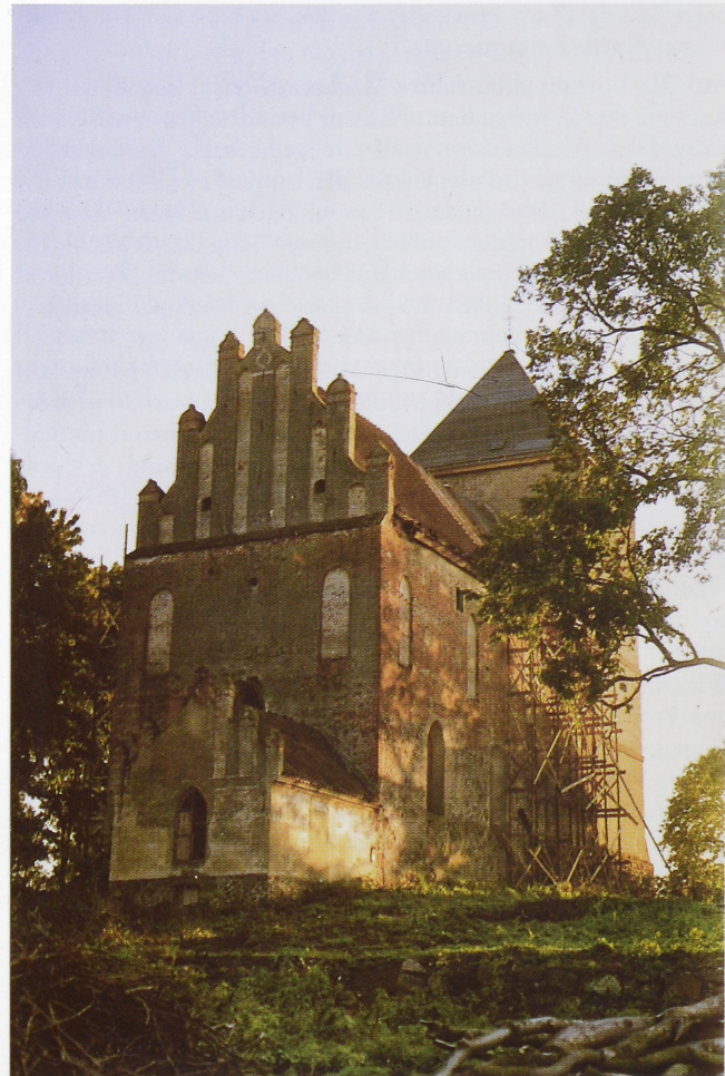
Abb. 14. Das zur Kirche umgebaute Wildhaus Bäsclack 1987 (von Osten, Foto: Tilla v. der Goltz).
