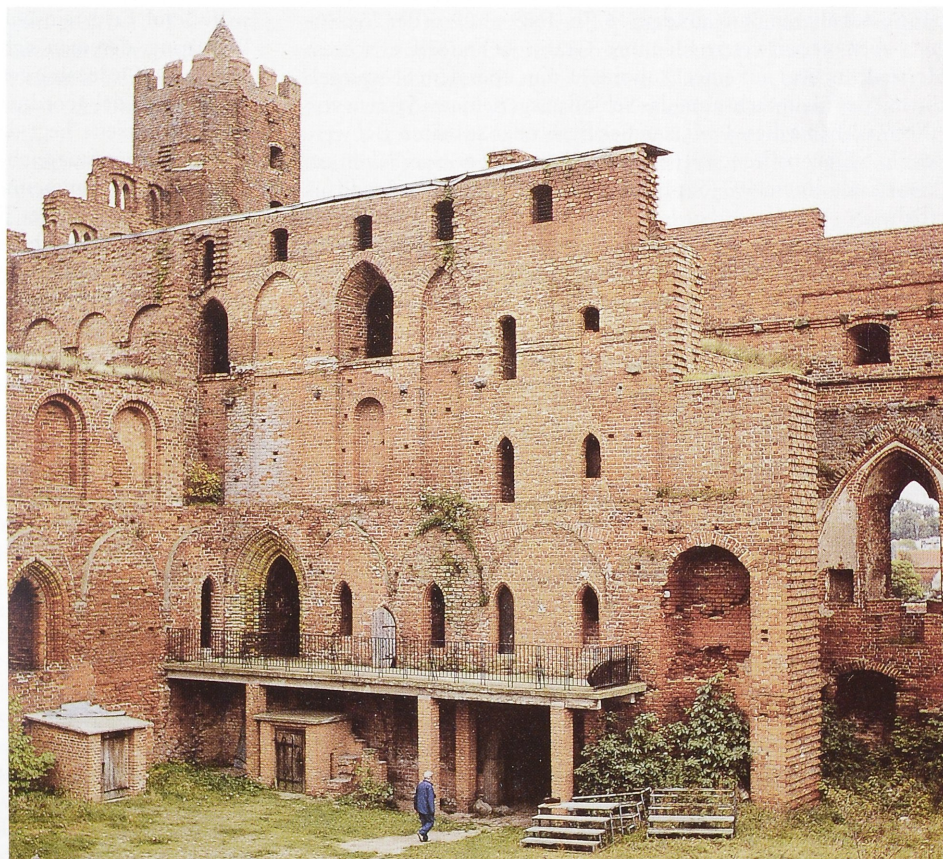
Abb. 6. Deutschordensburg Rehdén/Radzyn, Hauptflügel, Innenseite (Foto: G. Schmitt).
