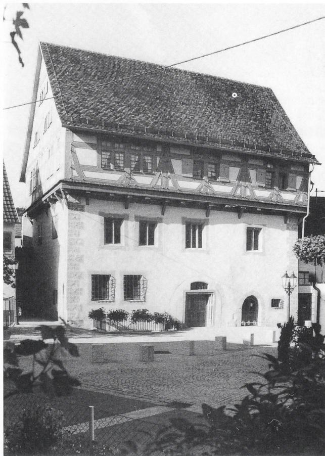
Abb. 3. Neuffen, „Großes Haus“ der Schilling von Cannstatt. Sockelgeschloß und darüberliegende Balkenlage von 1364 (d), Umbau mit Hinzufügung des Fachwerkoberbaus 1595. Gelbfassung des Fachwerks mit schwarzer Schattierung der Gefache und gemalte Kantenquaderung sowie Rahmung der Fenster im Sockelbereich. Wiederherstellung nach Befund.
