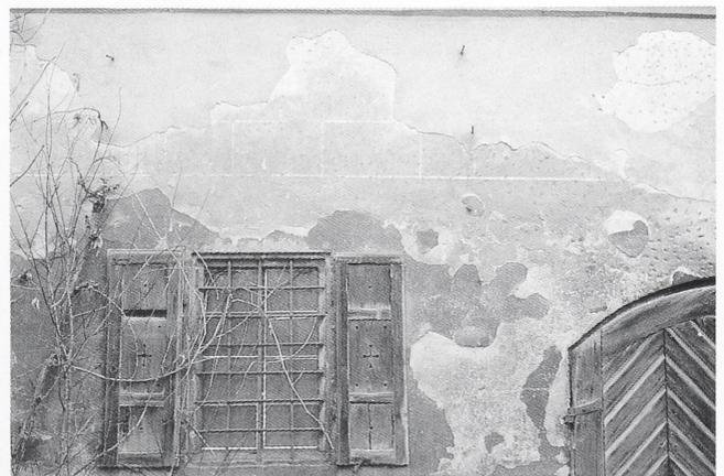
Abb. 8. Schloß Köngen, Sockelgeschoß des Ostflügels. Unter späteren Putzschichten kommt der verputzte massive Sockel mit aufgemaltem Fugennetz zutage. Befund.
