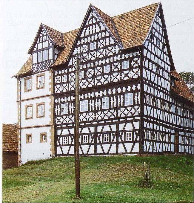
Abb. 5. Sternbergschloß in Meeder. Der ältere Fachwerkbau aus der Mitte des 16. Jh.s wurde um 1600 um den massiven Bauteil mit roter Kantenquaderung erweitert. In der Baufuge zwischen Fachwerkbau und Massivbau hatte sich die ursprüngliche schwarze Fachwerkfassung mit Verbreiterung in die Gefache und gleichfalls schwarzen Begleitlinien, die sich in den Gefachecken überschneiden, erhalten. Wiederherstellung nach Befund.
