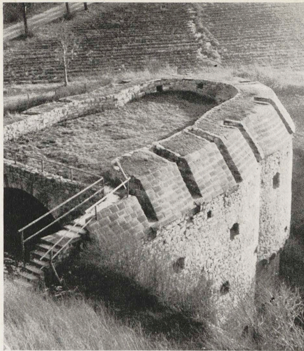
Abb. 8 Burg Querfurt. Südlicher Batterieturm. Blick auf die Wehrplatte und die restaurierte Brustwehr mit Kanonenscharten.
