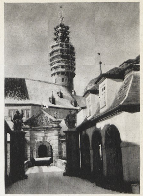
Abb. 5 Holzschutzbehandlung in der Turmkonstruktion am Fürstlich Hohenloheschen Schloß Weikersheim/Württ.
