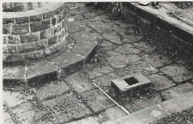
Abb. 3 Zisternenabdeckung mit Einlaßstein. Burg Landeck (Pfalz)
