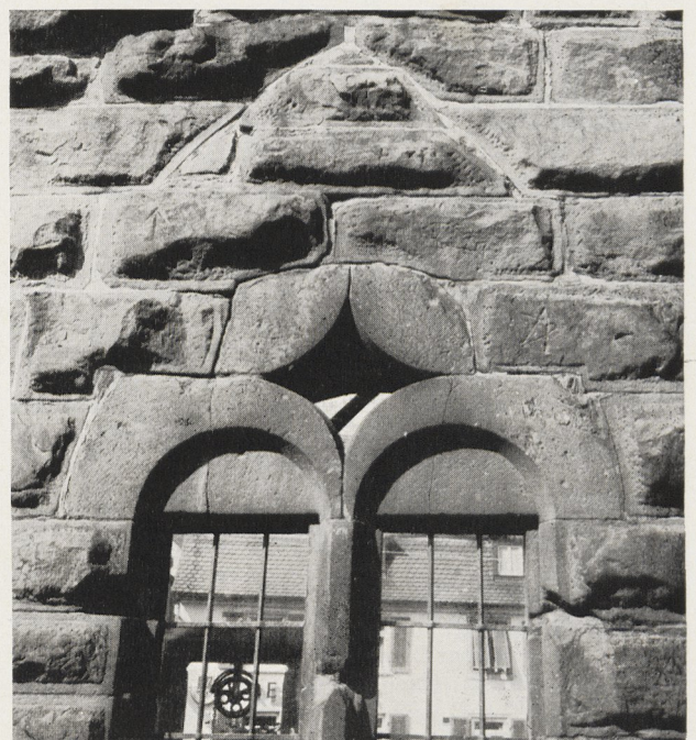
Abb. 9 Burg Lahr. Fenster des Palasuntergeschoßes (die Steinmetzzeichen Nr. 9, 10, 28 und 58 sind zu erkennen)
