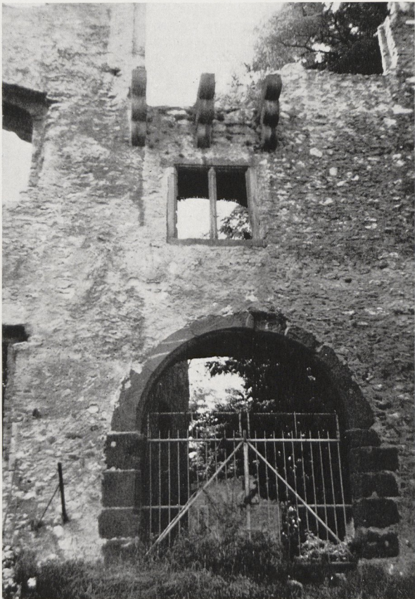
Abb. 14 Ruine Oppenheim: Ostseite von außen mit großem Tor und Konsolen (Basis eines Erkers). Siehe auch Abb. 21 auf Seite 42
