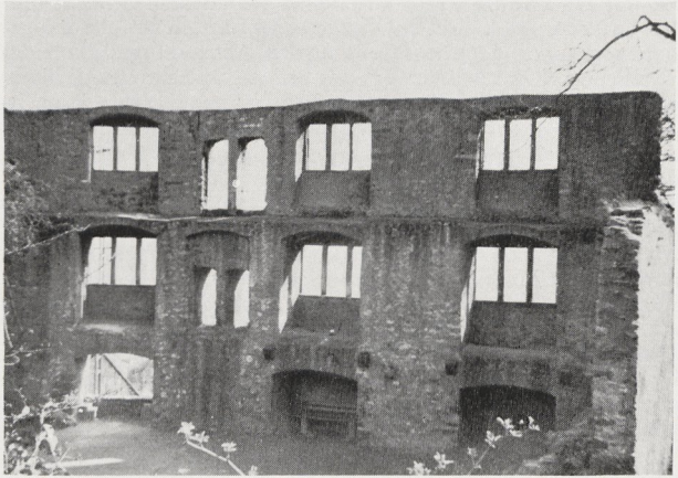
Abb. 13 Ruine Oppenheim: Innenseite der Palas-Außenwand. Regelmäßige Fensteranordnung, links Zugänge zu den Doppelabortanlagen
