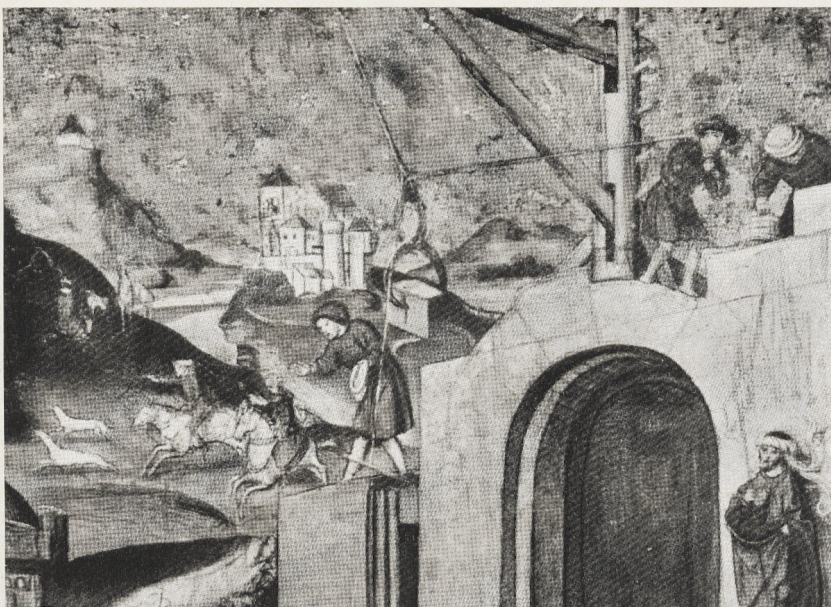
Abb. 5 Baustelle mit Hebewerkzeug und Bauleuten (Kat. 49: Erbauung des Stifts Klosterneuburg. Um 1495)
