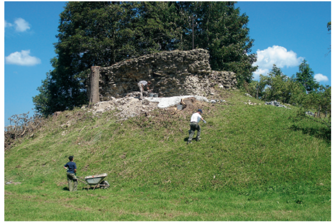
Abb. 13. Erlebnisbaustelle Burg Schöneberg. Zustand während der Sanierung.
