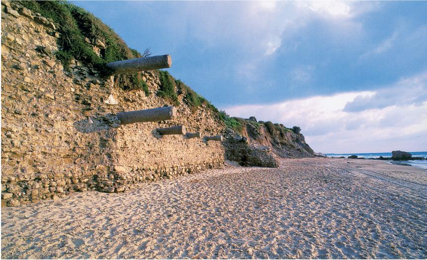
Abb. 2. Askalon, ehemalige Seemauer mit zur Verstärkung der Mauern eingelegten Säulen, die nach Abtragung bzw. Abwitterung der äußeren Mauerteile stehen blieben (aus: Mathias Piana [Hrsg.], *Burgen und Städte der Kreuzzugszeit*, Petersberg 2008, Abb. 9, S. 268).
