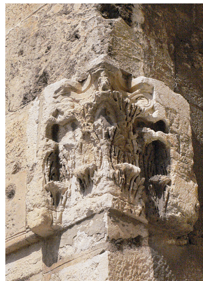
Abb. 11. Jerusalem, Kapitell, aus Abbruch in der Stadtmauer verbaut.
