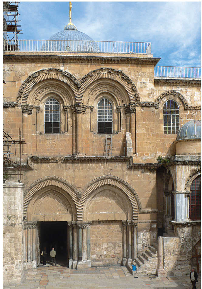
Abb. 12. Jerusalem, Grabeskirche, Fassade (alle Fotos: Verf.).
