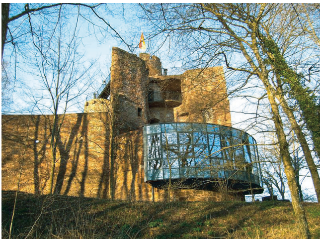
Abb. 5. (Neu-)Montclair; Blick auf den Südostturm mit moderner Gaststätte (Foto: Verf.).
