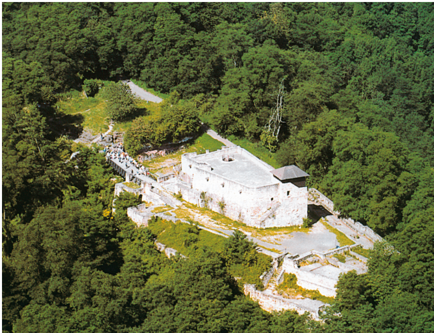
Abb. 11. Luftaufnahme der Burgruine (Neu-)Felsberg („Teufelsburg“) im deutschen Bellistum (Verwaltungsbezirk) des Herzogtums Lothringen, Landkreis Saarlouis (Foto: M. Czerwinski, aus: E. Sander, Die schönsten Schlösser und Burgen im Saarland, Gudensberg-Gleichen 1999, S. 29 ).
