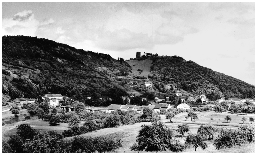
Abb. 7. Ruine Siersburg, Zustand um 1955 (Foto: Verf.).
