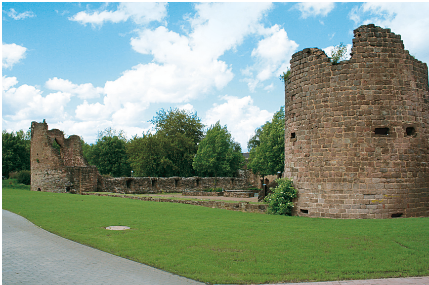
Abb. 4. Burgruine Bucherbach, Stadt Püttlingen, Sanierung 1980er-Jahre (Foto: Verf.).
