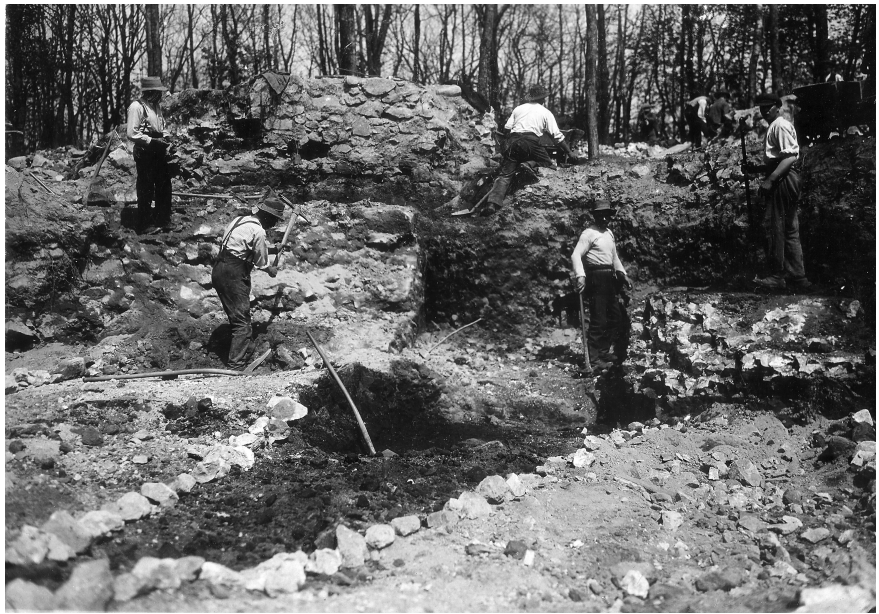
Abb. 2. Schaumburg, Tholey, Fundamentarbeiten zur Errichtung des Kaiser-Wilhelm-Turmes 1914 (Verf.).
