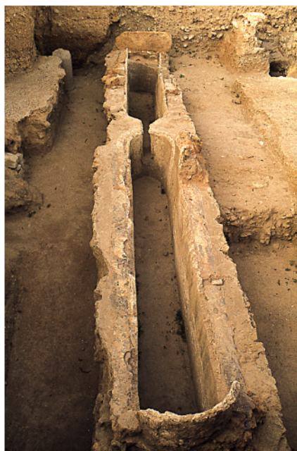
Abb. 1. Doppelzisterne in einer der großen Küstenvillen des punischen Karthago, Tunesien, 2. Jahrhundert v. Chr. Innenwandung und Schulter der Zisterne sind mit Kalkmörtel bedeckt, der durch die Beimengung von Holzkohlenasche und Glattschliff wasserdicht gemacht wurde, dabei den zementgrauen Farbton erhielt; darüber haftet ein heller Kalkmörtel von der römischen Wiederverwendung der Zisterne. Die seitlichen Korridors, in dessen Boden die Zisterne nachträglich eingeschlitzt wurde, sind in römischer Zeit zur Gewinnung von Baumaterial ausgebaut, die Raubgruben anschließend verfüllt worden (Foto: Verf.).
