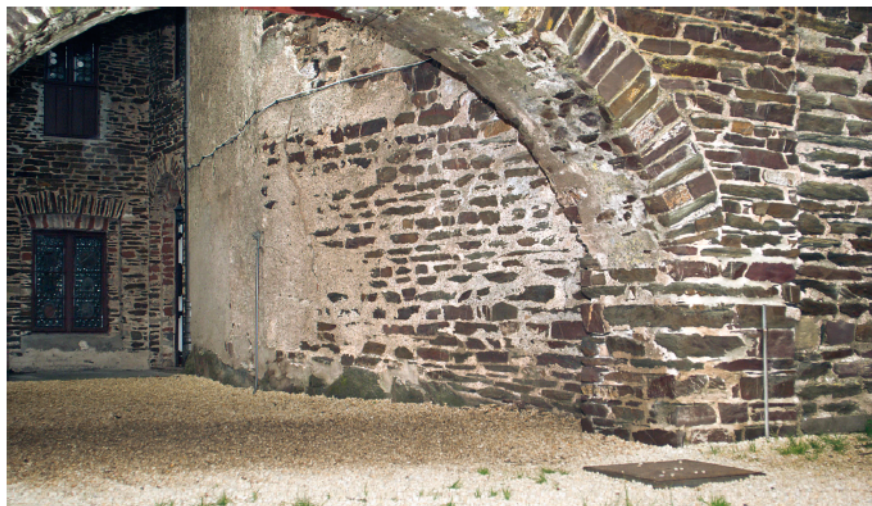
Abb. 7. Cochem. Sockelbereich. Der angesetzte Bogen ist modern (Foto: J. Zipfel, 2007).
