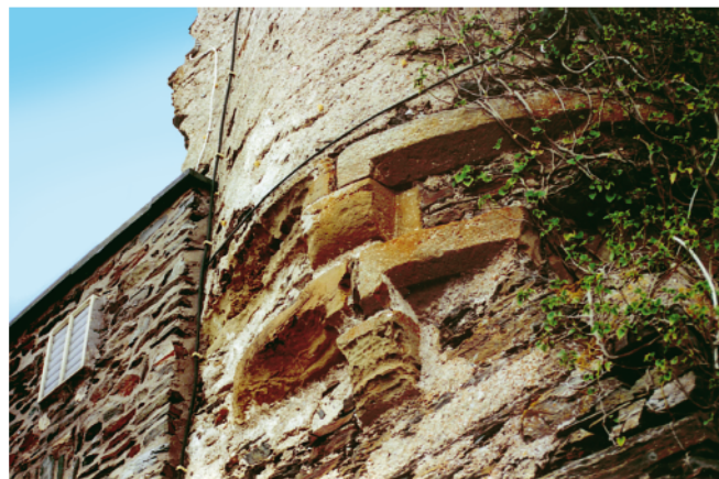
Abb. 4. Bernkastel. Werksteinsockel der Tourelle (Foto: Verf., 2006).
