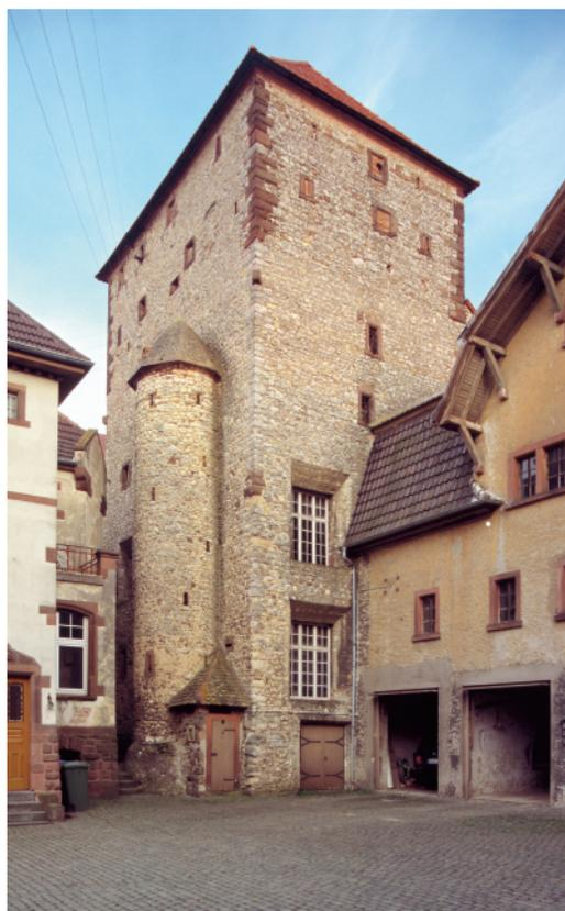
finden. Auch hier wurde ein zwar älteres, aber nicht ursprüngliches Fenster ersetzt. Allerdings lässt die Analyse des Inneren vermuten, dass das andere Fenster, nahe dem Treppenturm gelegen, anstelle eines originalen Fensters eingesetzt wurde.
