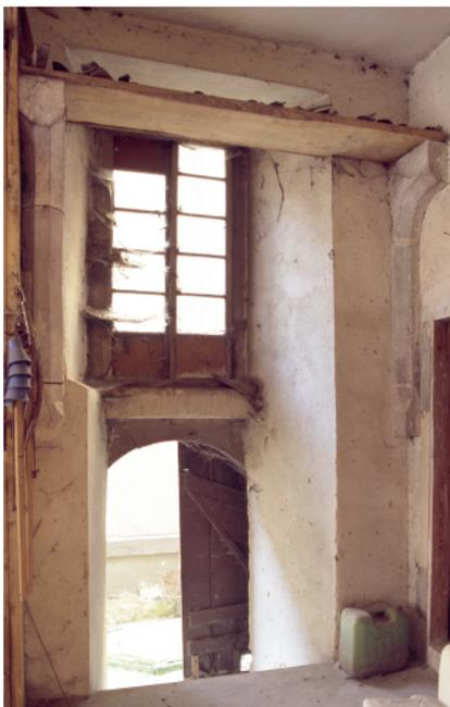
Abb. 10. Kaminsäulen im Erdgeschoss, dazwischen sekundär Tür und Fenster, 2006 (Foto: Uwe Welz).
