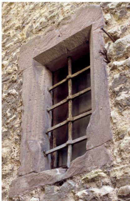
Abb. 7. Bauzeitliches Fenster im Erdgeschoss mit Ablaufstein, 2006 (Foto: Uwe Welz).
