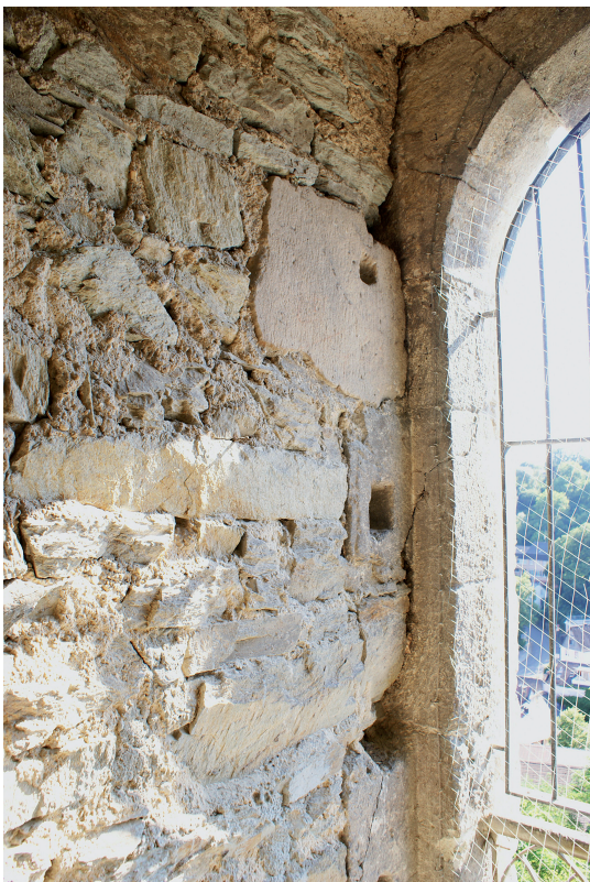
Abb. 7. Südliche Hälfte des ursprünglichen Eingangs auf der Westseite des ersten Obergeschosses mit mehreren, teilweise nachträglich ausgestemmt Löchern für hölzerne und eiserne Riegelbalken (Foto: Verf.).
