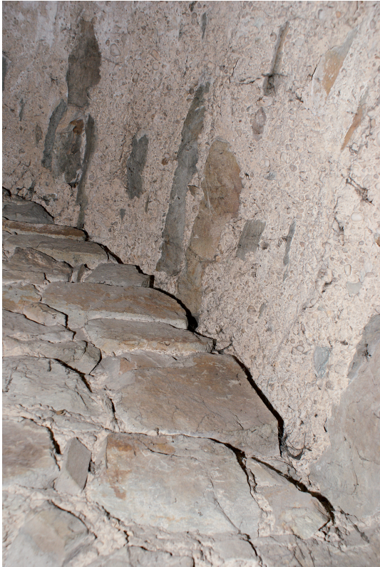
Abb. 6. Sockelgeschoss, Ausschnitt aus dem Zusammentreffen von Gewölbe und Südwand in der Südwestecke, Schräguntersicht von Nordosten. Die Gewölbeschulung lag relativ knapp auf der Schildwand und hat dort nach ihrer Beseitigung eine Nut hinterlassen (Foto: Verf.).
