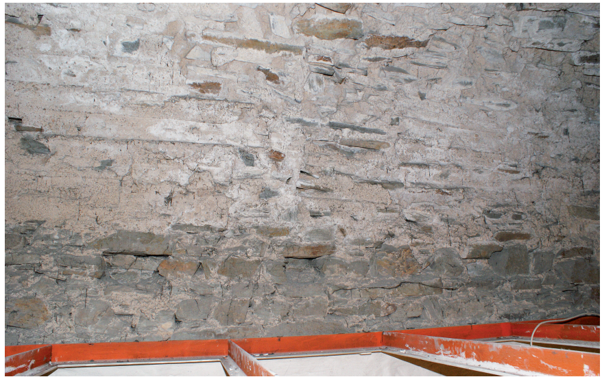
Abb. 5. Sockelgeschoss, Ostwand und Tonnengewölbe oberhalb der neuen Zwischendecke. Über dem mittleren der drei Löcher für die Balken des Lehrgerüsts zeichnet sich die Zäsur zwischen den beiden Hälften der Schalung ab (Foto: Verf.).
