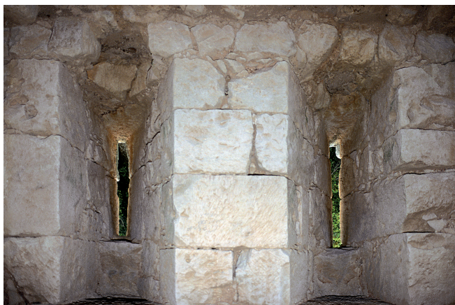
Abb. 20. (Links) al-Bāra , Qal'at Abū Sufyān , Schießscharte (11. Jahrhundert) mit vorgelagerter Schießkammer an der Nordseite im 3. Geschoss des Turms.
