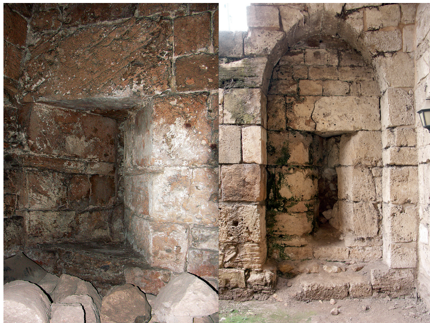
Abb. 22. Montpèlerin (arab. Qal'at Saṅṅīl ), Schießscharten: links einfache Mauerscharte im südöstlichen Turm der äußeren Ringmauer; rechts Scharte mit Nische an der südlichen Zwingermauer.
