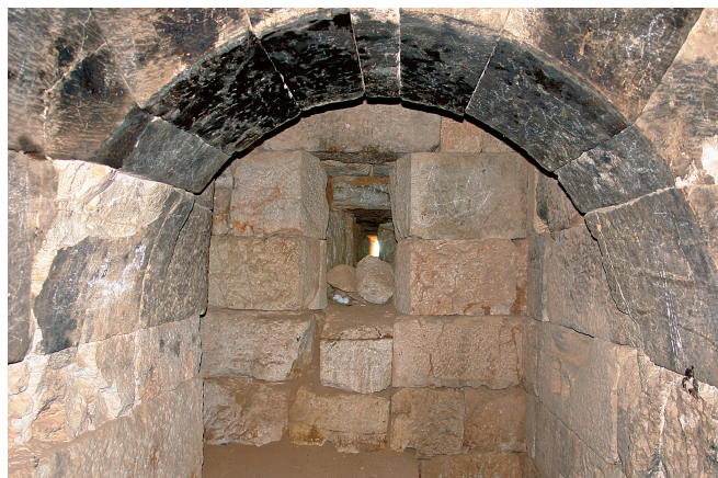
Abb. 20. (Links) al-Bāra , Qal'at Abū Sufyān , Schießscharte (11. Jahrhundert) mit vorgelagerter Schießkammer an der Nordseite im 3. Geschoss des Turms.
