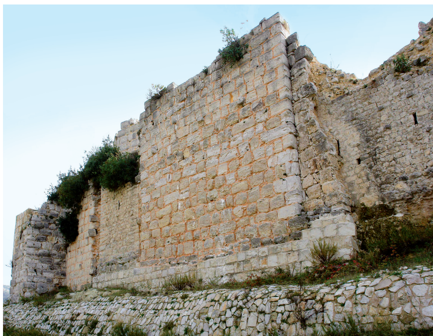
Abb. 4. Menikos (arab. Qalʿat al-Manīqa ), nordwestliche Ringmauer der Burg, die 1027 vom byzantinischen Katepan von Antiochia errichtet wurde. Das Mauerwerk der Gründungsanlage ist hinter der abgefallenen Mauerschale rechts im Bild zu erkennen, links ein Turm.
