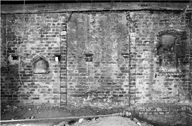
Abb. 12. Messbild zu Südwand im zweiten Obergeschoss mit Resten eines offenen Kamins, einem kleinen Wandschrank und einer Nische mit giebelförmigem Sturz der Bauphase 3 im Jahr 2001.
