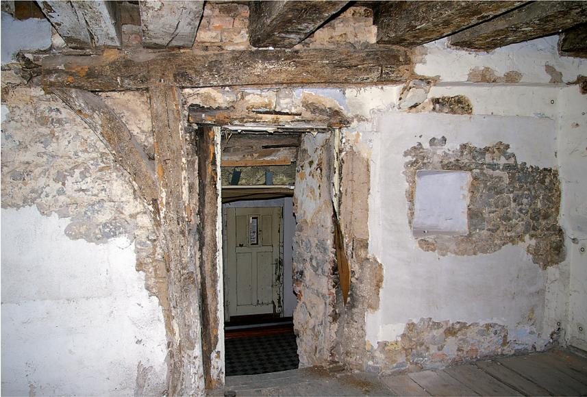
Abb. 9. Westwand im erhöht gelegenen Erdgeschoss mit Zugang vom Vorderhaus, Schlitzfenster des Gründungsbaues und Deckenkonstruktion der zweiten Hälfte des 12. Jahrhunderts (Foto: M. Hensch, Untere Denkmalbehörde Duisburg).
