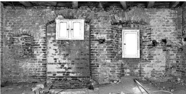
Abb. 13. Messbild zu Ostwand im zweiten Obergeschoss, neuzeitlich überformten Fenstern und Nischengliederung zwischen erstem und zweitem Obergeschoss, im Jahr 2001.
