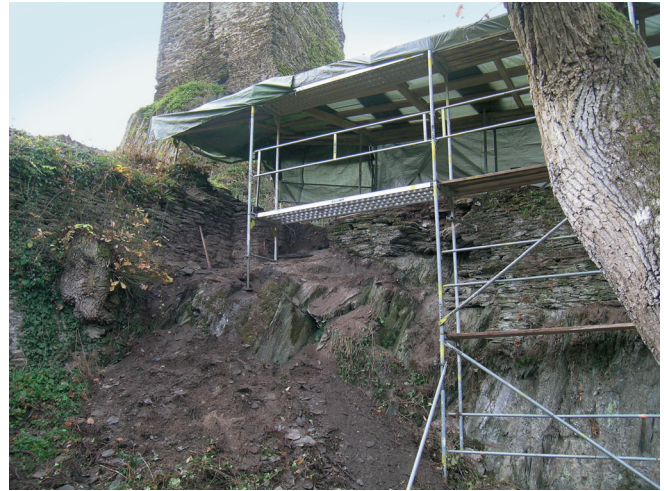
Abb. 2. Sicherungsarbeiten an Burg Stahlberg unweit des rechteckigen Palas (Foto: Rheinischer Verein, 2005).
