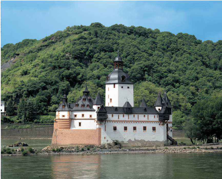
Abb. 1. Der Pfalzgrafenstein von Osten (Zustand vor der Restaurierung) (Foto: LAD; Heinz Straeter).
