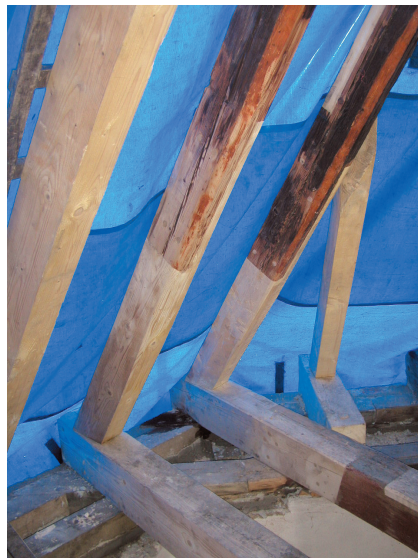
Abb. 24. Reparierter Sparrenfuß (Foto: wie Abb. 21).
