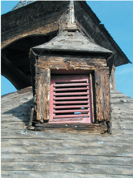
Abb. 27. Gaupe vor der Überarbeitung (Foto: wie Abb. 21).
