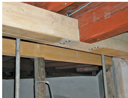
Abb. 26. Ausgetauschter Unterzug der Südspitze (Foto: wie Abb. 21).
