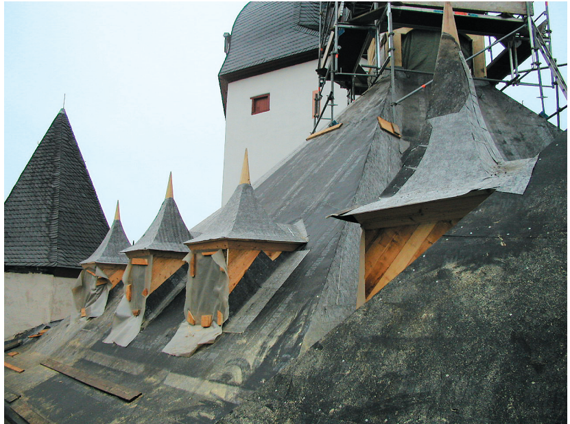
Abb. 28. Gauben der Ostseite nach der Überarbeitung (Foto: wie Abb. 21).
