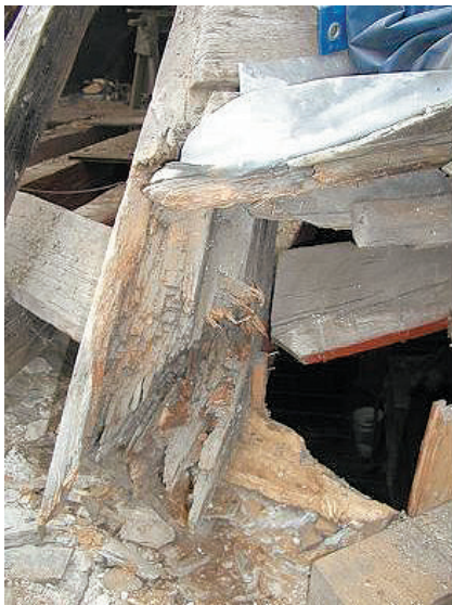
Abb. 23. Zerstörter Sparrenfuß (Foto: wie Abb. 21).
