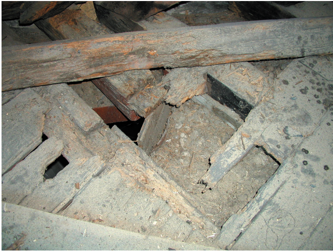
Abb. 21. Südwestliche Ecktourelle, zerstörter Kehlbereich (Foto: LBB, Koblenz; Christiane Gabel).
