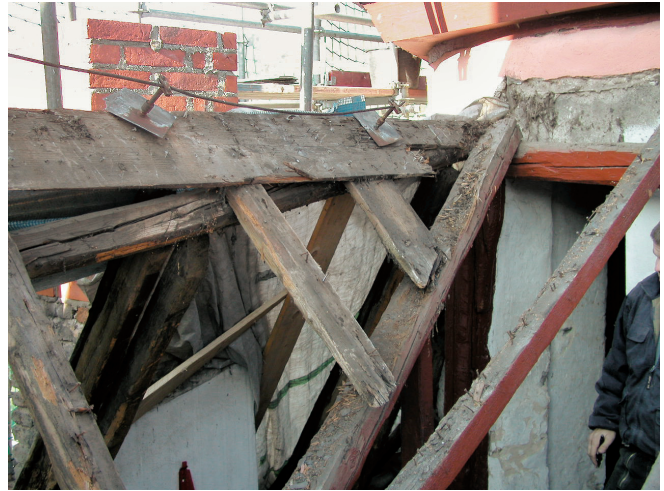
Abb. 21. Südwestliche Ecktourelle, zerstörter Kehlbereich (Foto: LBB, Koblenz; Christiane Gabel).
