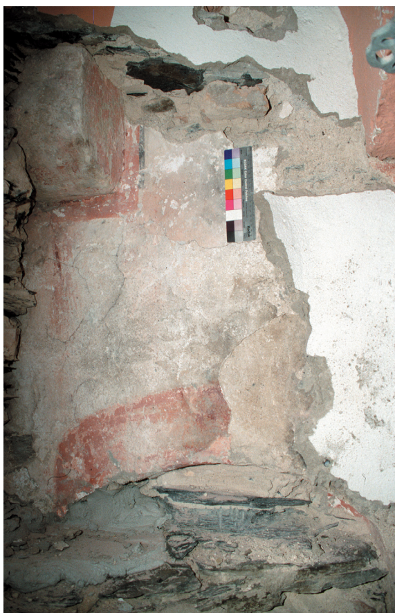
Abb. 20. Farbbefunde an der Südosttoureille (Foto: Karen Keller, Köln).
