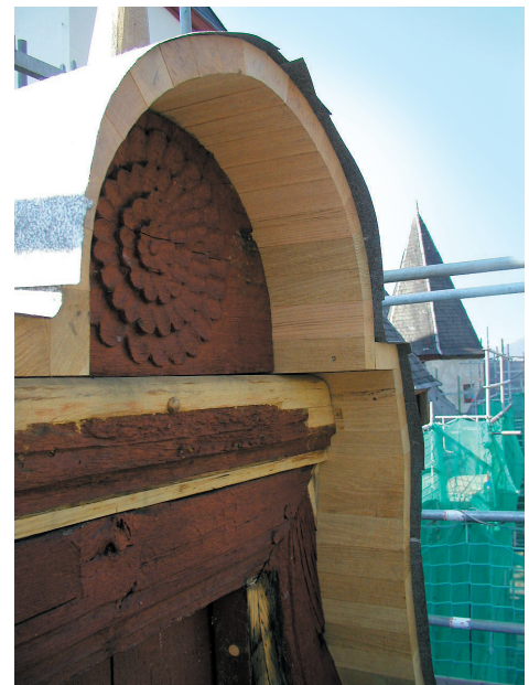
Abb. 29. Auslugerker, Giebfeld mit ausgetauschter Rahmung (Foto: wie Abb. 21).
