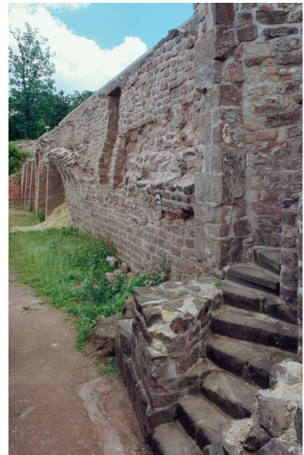
Abb. 11. Ruine Homburg. Kellergewölbe des Großen Zeughauses (von Westen). Im Vordergrund die Treppenspindele einer sekundären Bauphase (Foto: U. Welz, 2005).
