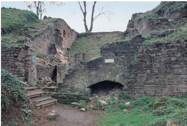
Abb. 9. Ruine Homburg. Kellergewölbe eines Gebäudes der Osterweiterung mit zwei übereinander liegenden Räumen (von Süden) (Foto: U. Welz, 2005).
