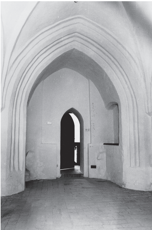
Abb. 23. Burgkapelle im Torturm, Fenster zum Hof verblendet (Foto: B. Sanko, 1989).
