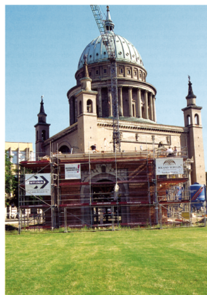
Abb. 4. Potsdam, Kopie des „Fortunaportals“ des Stadtschlösses, 2001 (Foto: Aribert Kutschmar).
