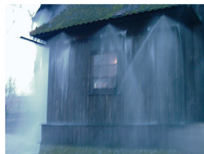
Abb. 6. Beispiel einer Wasserebelllöschanlage an einer Holzkirche (FOG, SUPO Cerber Krakow, Polen); oben Löschprobe außen, unten Löschdüse innen.
