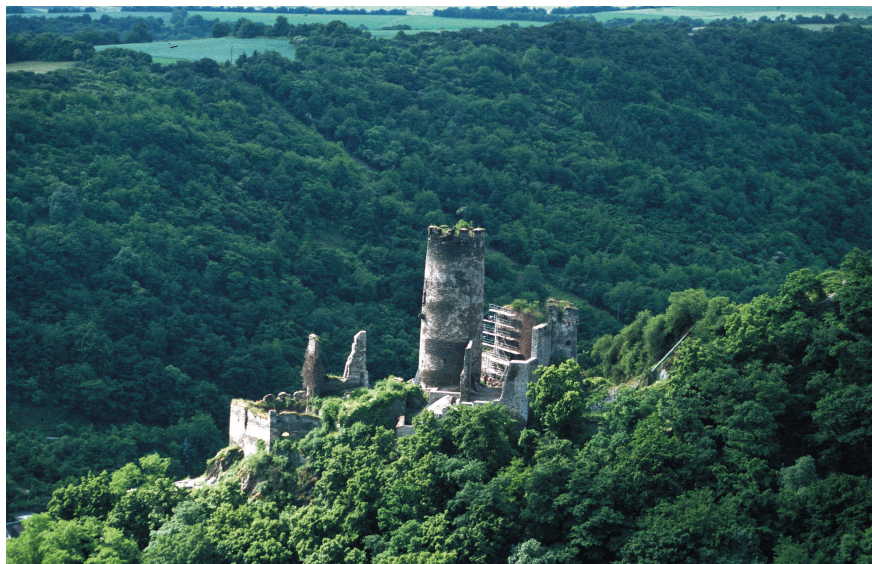
Abb. 1. Burgruine Fürstenberg bei Rheindiebach, Ansicht von Osten (Foto: Verf.).
