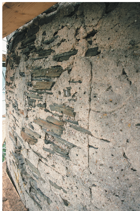
Abb. 6. Burgruine Fürstenberg, Bergfried, Südseite mit originalen Putzflächen.
