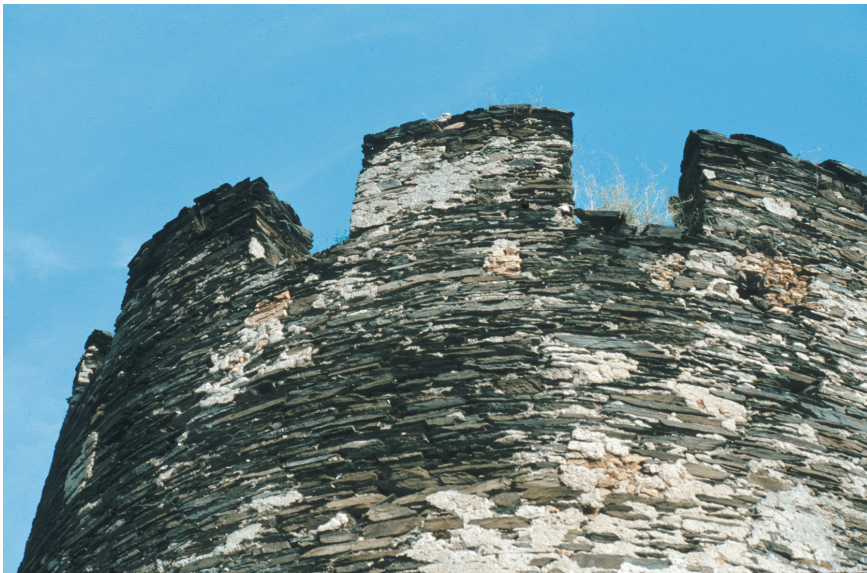
Abb. 13. Burgruine Fürstenberg, vermauerte Balkenlöcher des äußeren Umganges und Reparaturstellen im Mauerwerk (Foto: Verf.).
