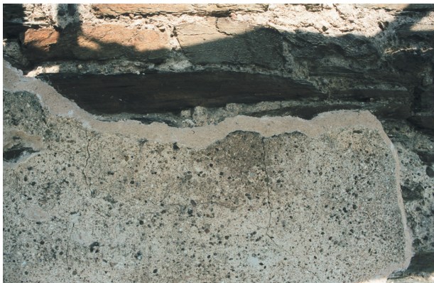
Abb. 14. Burgruine Fürstenberg, restauratorische Putzsicherung (Kantenanbösungen und Injektionen mit Kalkmörtel) (Foto: Verf.).
