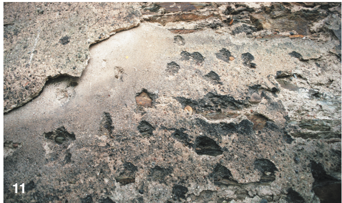
Abb. 8. Burgruine Fürstenberg, Waagerechte Putzkante („Pontate“) mit Spuren der Rotfassung (Foto: Verf.).
