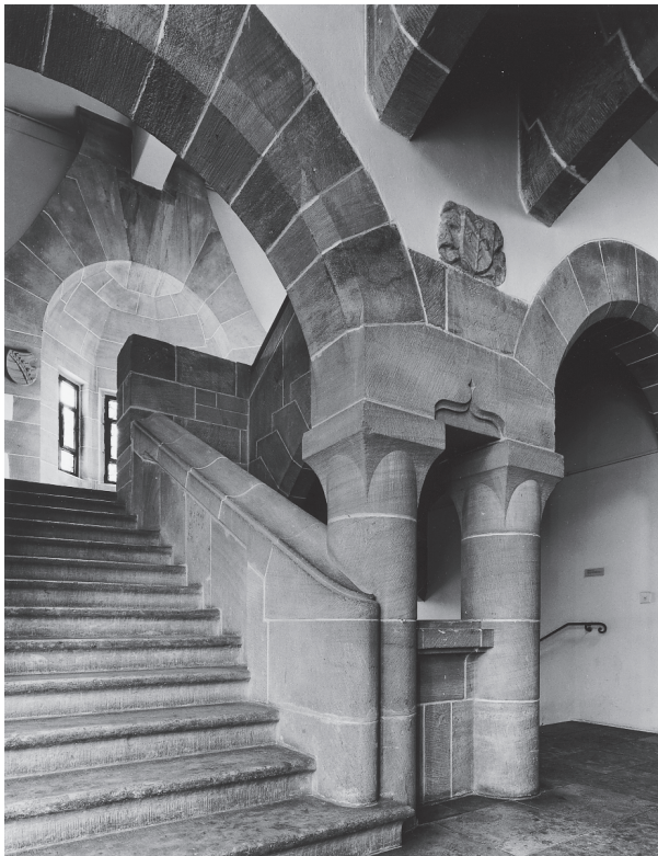
Abb. 3. Veste Coburg, Bayern, Treppenhaus im Carl-Eduard-Bau, 1923. „Eine mächtige Steintreppe eigenartigen Steinschnittes“ (Nachrichten über die Bauarbeiten 1921, S. 8, maschinenschr., EBI) dokumentiert den Wert, den Ebhardt auf handwerklich perfekte Ausführung bei seinen Bauprojekten legte. Zwischen den Bögen „signierte“ Bodo Ebhardt das Bauwerk mit seinem Lilienwappen (Foto: Ingo E. Fischer, 1996).
