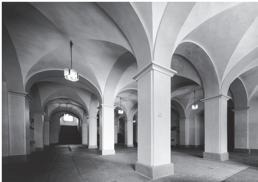
Abb. 4. Herrenhaus Gröditz, Sachsen, 1923. Der Wiederaufbau nach einem Brand gab Ebhardt die Gelegenheit zur Anlage einer „Großen Halle“ entsprechend seiner Schlossbautheorie. Die kräftigen Pfeiler auf quadratischem Grundriss sowie die Pilaster an den Wänden der Halle sind mit korbogigen Gurtbögen verbunden (Foto: Ingo E. Fischer, 1996).
