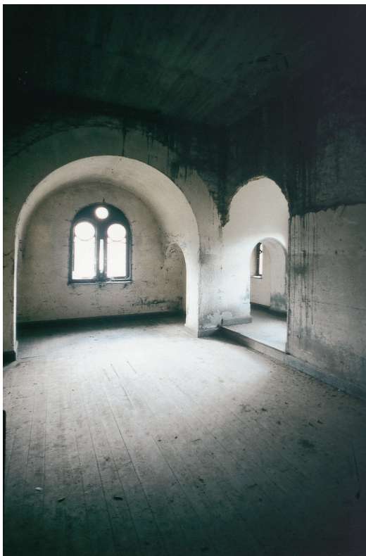
Abb. 1. Schloss Landonvillers, Lothringen, 1904–1906. Durch Doppelwand-Konstruktionen im Obergeschoss des „Donjons“ wird eine größere Wandstärke suggeriert. Außerdem haben sie laut Ehardt „Veranlassung zu sehr malerischen Raumbildungen gegeben“ (Müsebeck/Ehardt 1908, S. 23) (Foto: Verf., 1996).
